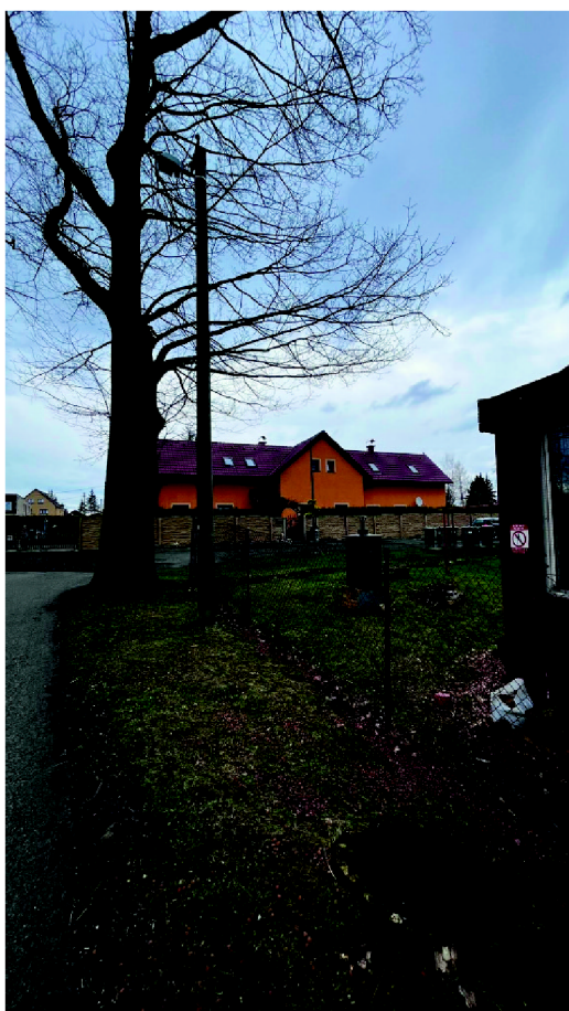
Obr. 8: Bývalá nádražní budova Dětřichov
