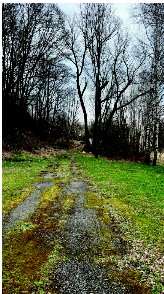
Obr. 12: Traťové těleso Heřmanice
