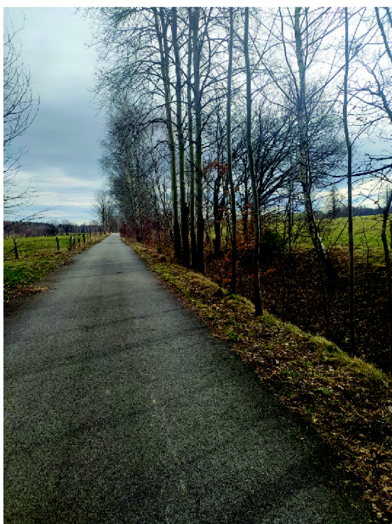
Obr. 19: Bývalé těleso tratě Jindřichovice - Mirsk
