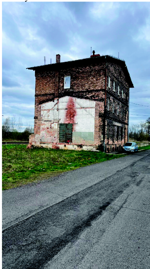
Obr. 6: Bývalá staniční budova Zawidów
