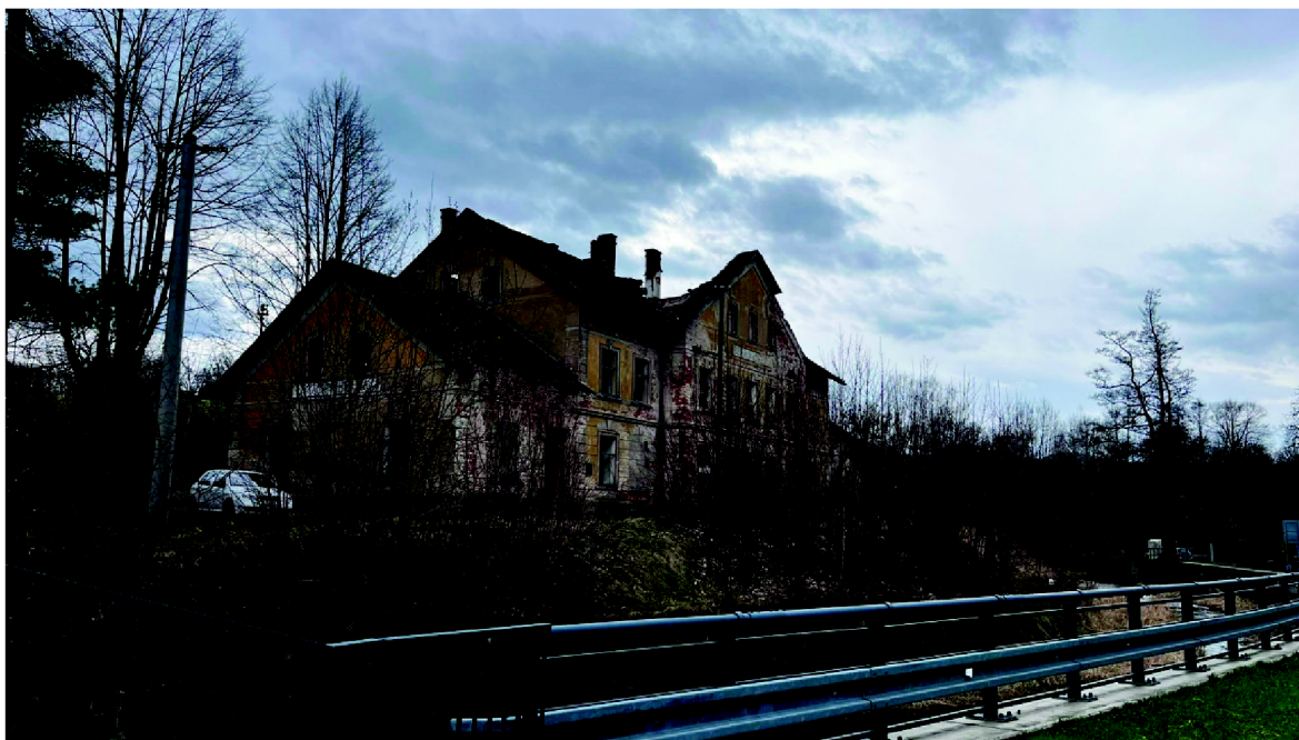
Obr. 10: Bývalé nádraží Heřmanice
