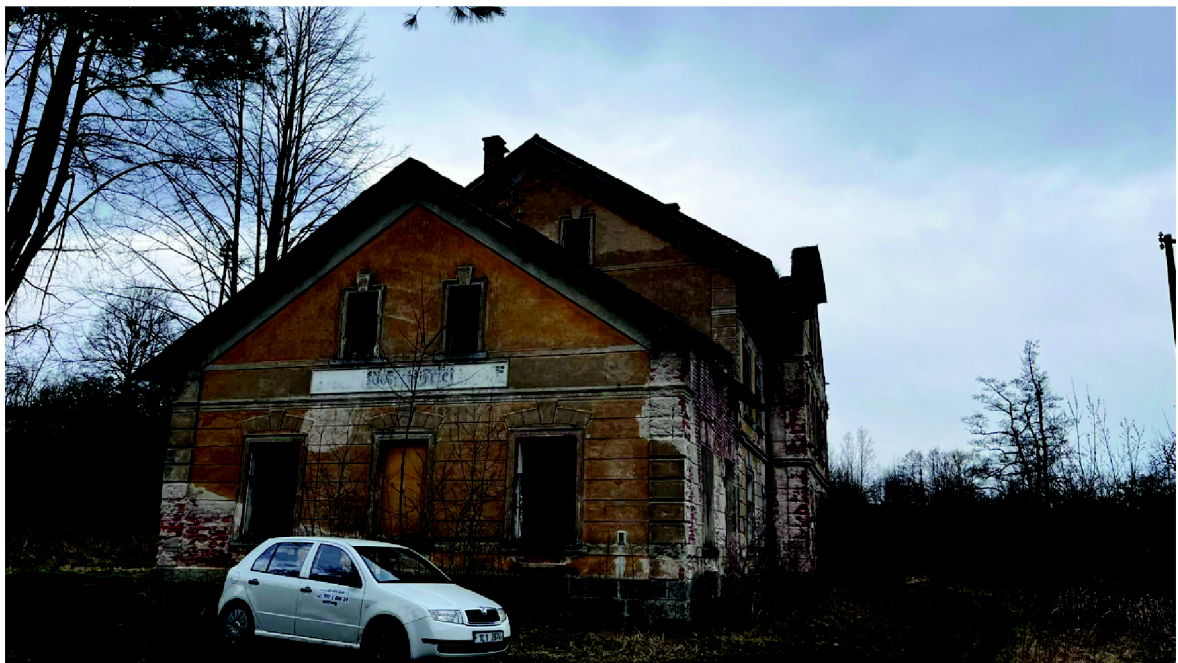
Obr. 17: Bývalá nádražní budova v Heřmanicích
