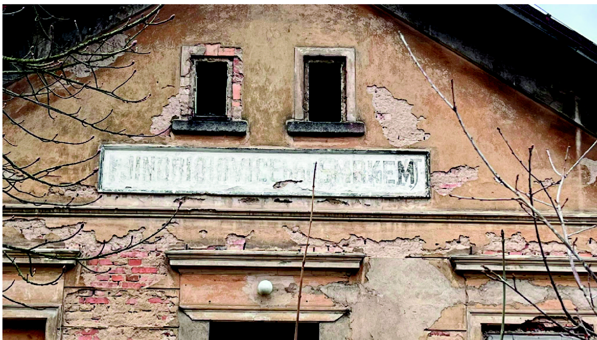
Obr. 18: Nápis na nádražní budově v Jindřichovicích p/S
