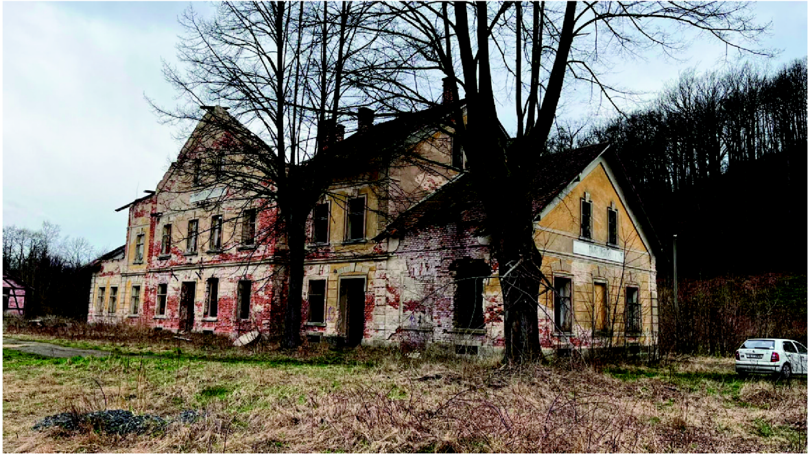
Obr. 16: Bývalá nádražní budova v Heřmanicích
