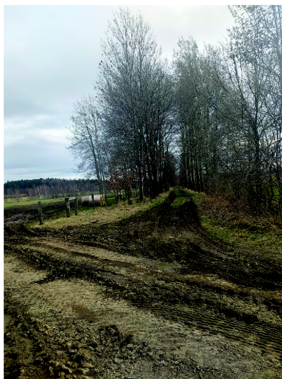
Obr. 20: Bývalé těleso tratě Jindřichovice - Mirsk
