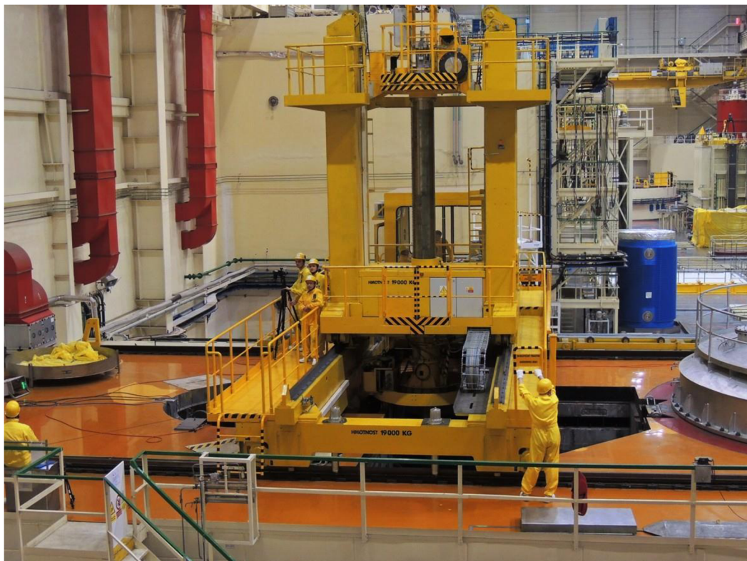
Obr. 6-1: Pohled na zavážecí stroj, který se nachází nad bazénem vyhořelého paliva, a na přípravu měření. JE Dukovany.
