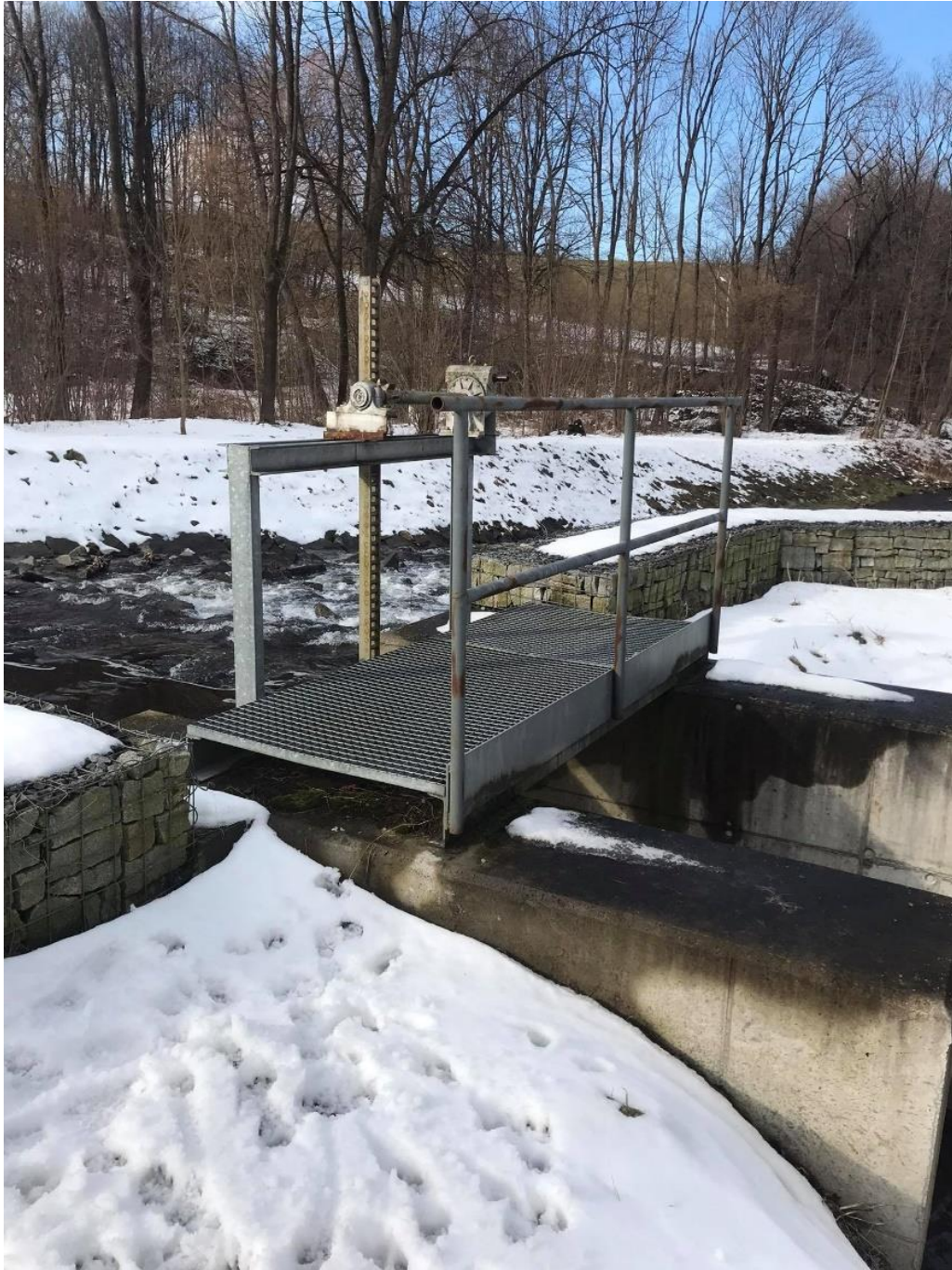
Příloha 3 – Fotografie opraveného stavidla po povodni 1997 v Kobylé nad Vidnavkou (Čecháčková, 2021).
