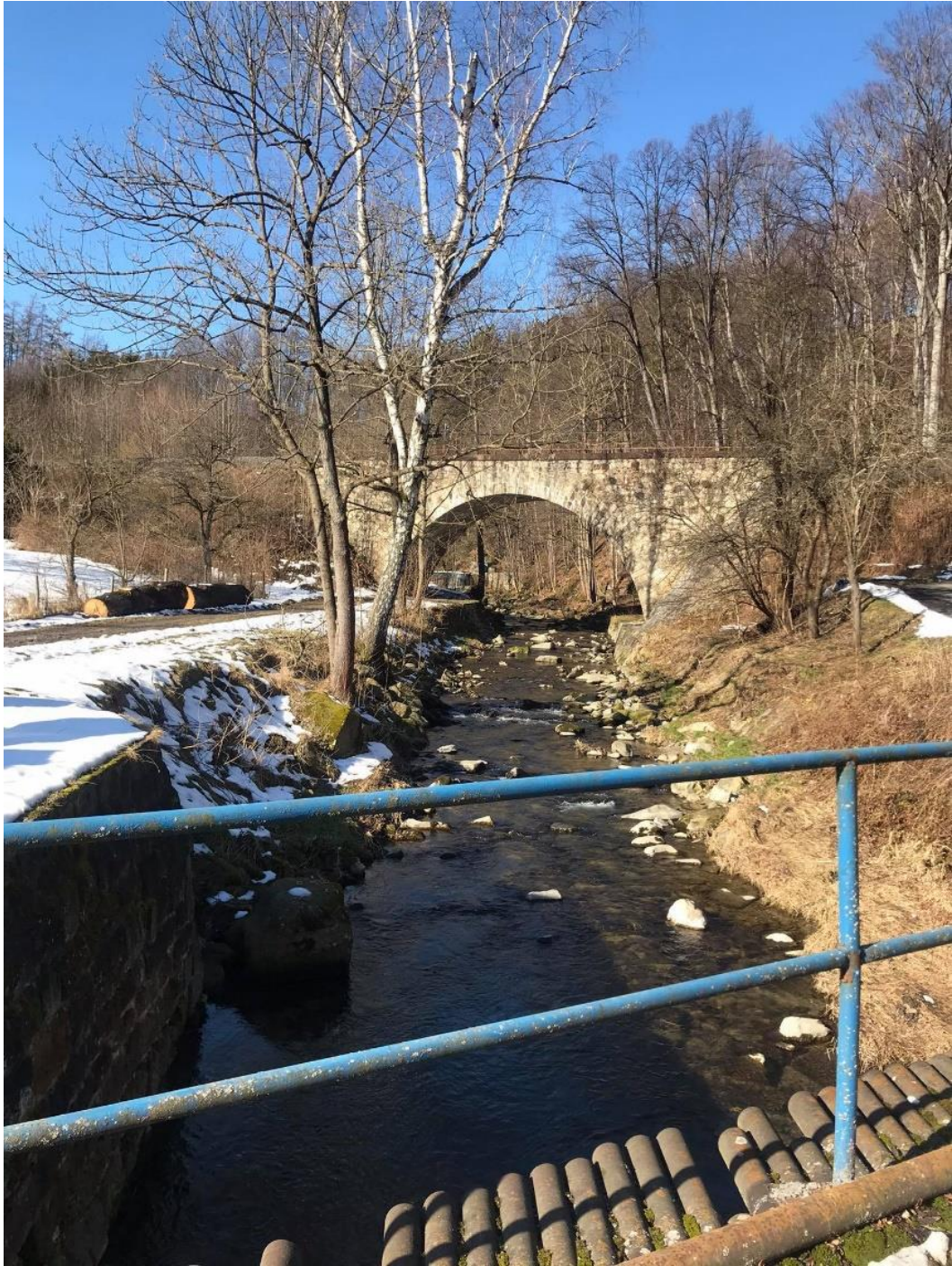
Příloha 5: Železniční most přes řeku Vidnavku v Tomíkovcích (Čecháčková, 2021)
