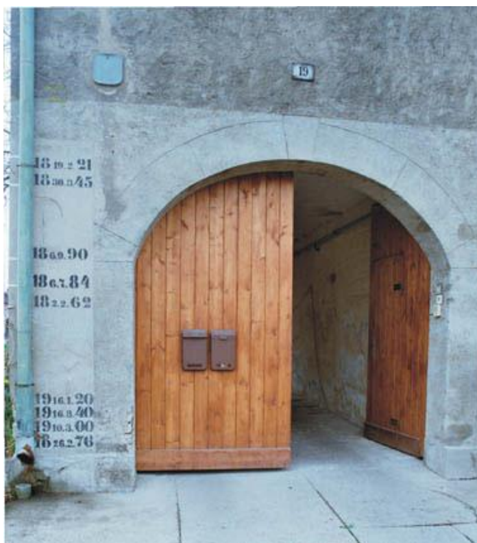
Obrázek 3 - Značky velkých vod v Křešicích na domě číslo popisné 19. Rozhraní světlejší a tmavší barvy nad vraty indikuje výšku, do které vystoupila voda v Labi při povodni v srpnu 2002. Zdroj : (foto L. Elleder).
