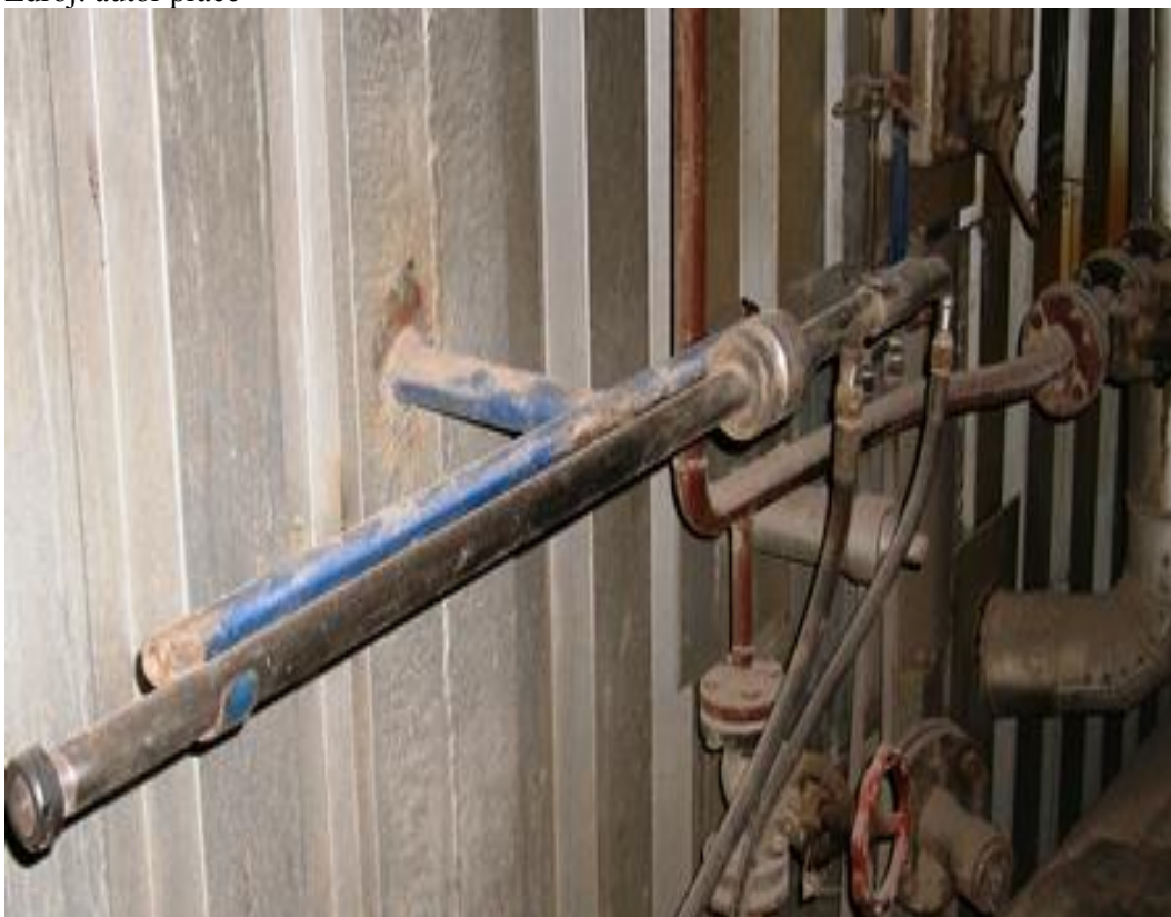
obr. č. 26 Nástřikové kopí směsi močoviny a vody SNCR – ZEVO Malešice Zdroj: autor práce
