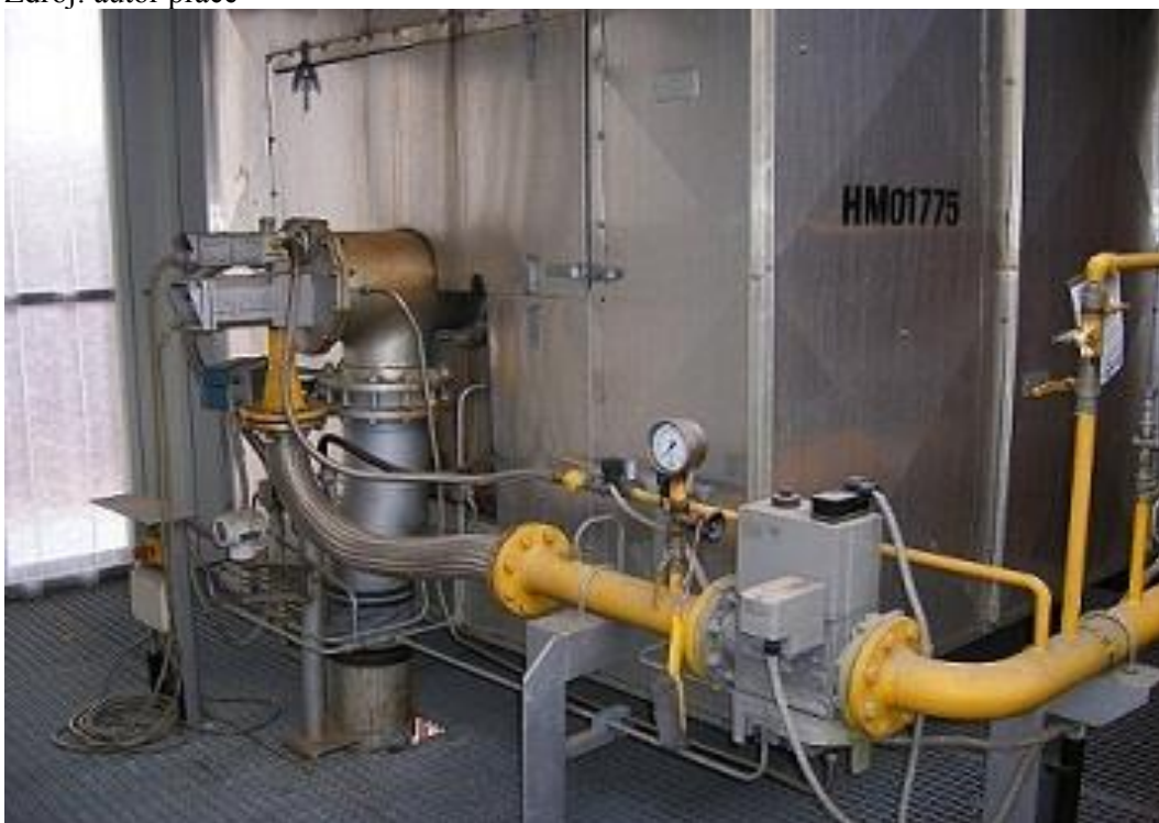
obr. č. 30 Plynový hořák pro zvýšení teploty spalin před nástřikem \text{NH}_3 Zdroj: autor práce
