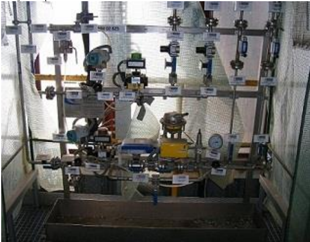
obr. č. 32 Ovládací a rozváděcí panel pro nástřik NH 3 do spalin – SCR Zdroj: autor práce
