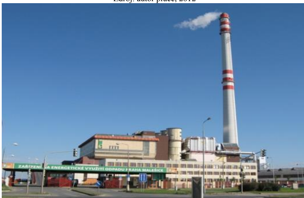
obr. č. 9 Zařízení pro energetické využití odpadu Malešice Praha - Pražské služby a.s. Zdroj: autor práce, 2012
