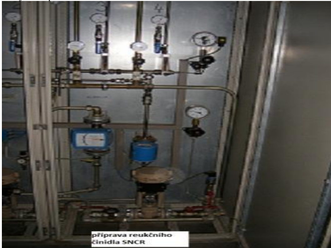
obr. č. 28 Výstroj směšovacího modulu pro přípravu směsi močoviny a surové vody SNCR Zdroj: autor práce
