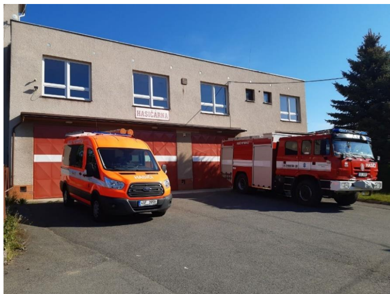
Obrázek 21 Požární zbrojnice JSDHO Petrovice s technikou, zdroj: vlastní
