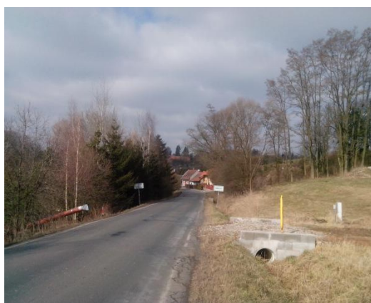
Obr. č. 30 Pohled z jižní strany 2014
