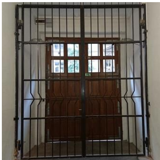
Obrázek 2: Vstup do budovy soudu zabezpečen vraty a mříží
