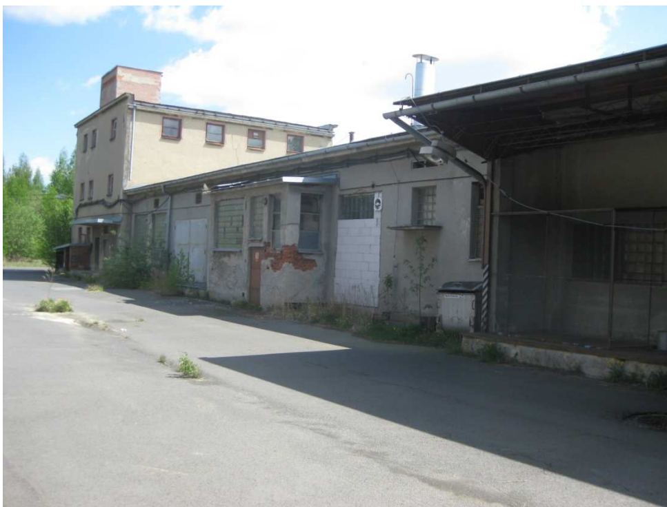
Obrázek 7 Fotografie zachycující výrobní halu na ulici Opavská v Bruntále
