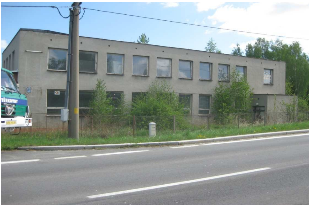
Obrázek 6 Fotografie správní budovy objektu na Opavské ulici v Bruntále
