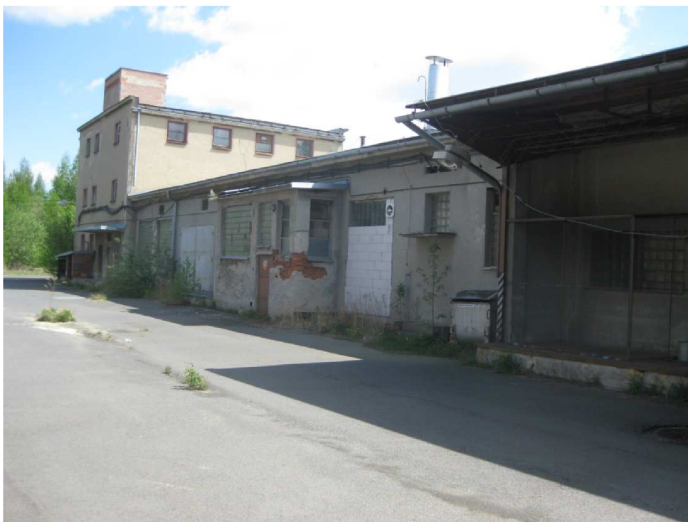
Obrázek 7 Fotografie zachycující výrobní halu na ulici Opavská v Bruntále
