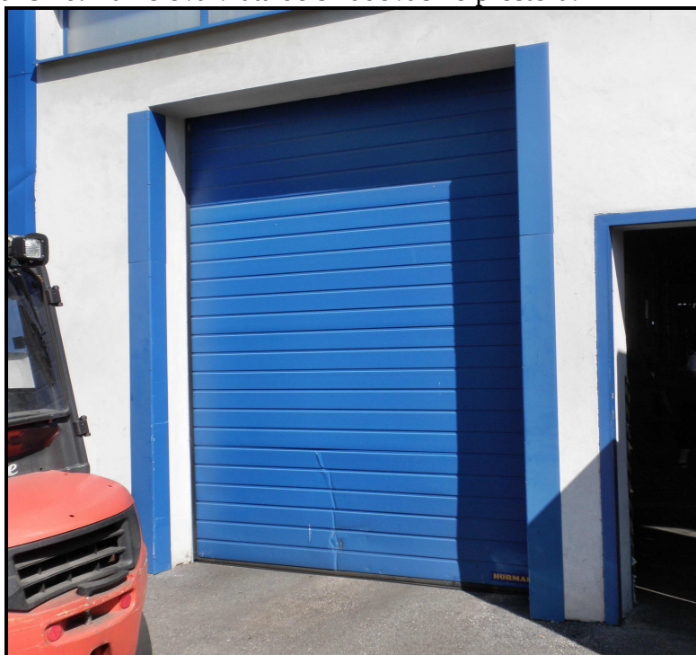
Obrázek 6: Lamelová vrata do skladovacího prostoru.
