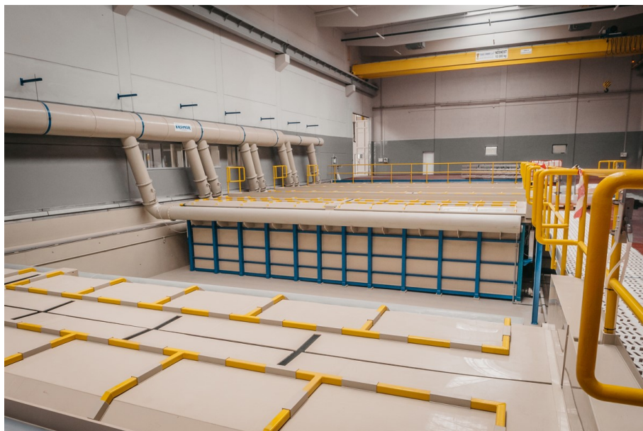
Obr. 22 Polypropylenové vany a VZT
