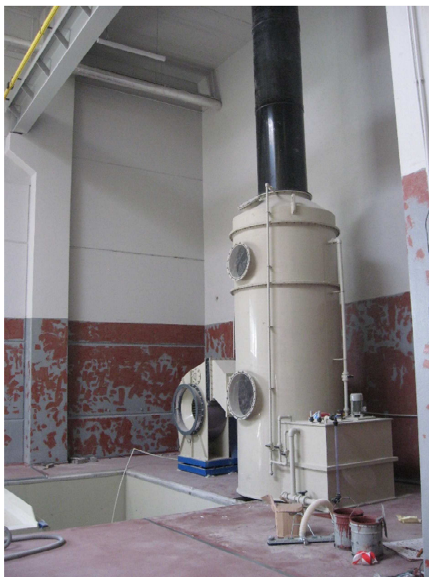
Obr. 23 Absorbér kyselých výparů
