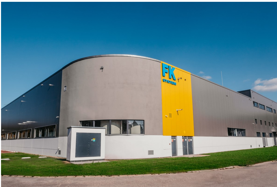
Obr. 18 Hala pro provádění povrchových úprav
