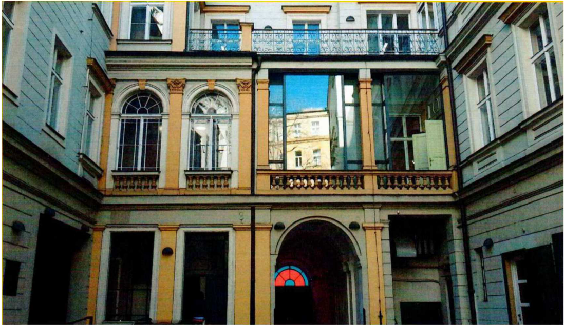
Obr. 27 Fotografie posuzované stavby
