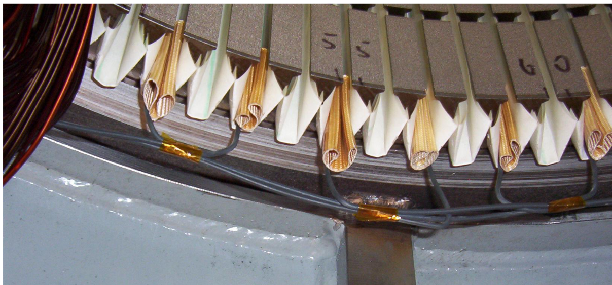
Obr. 3-4 Provizorní zajištění pomocného vinutí v drážkách pro následné manipulace při vkládání hlavního statorového vinutí
