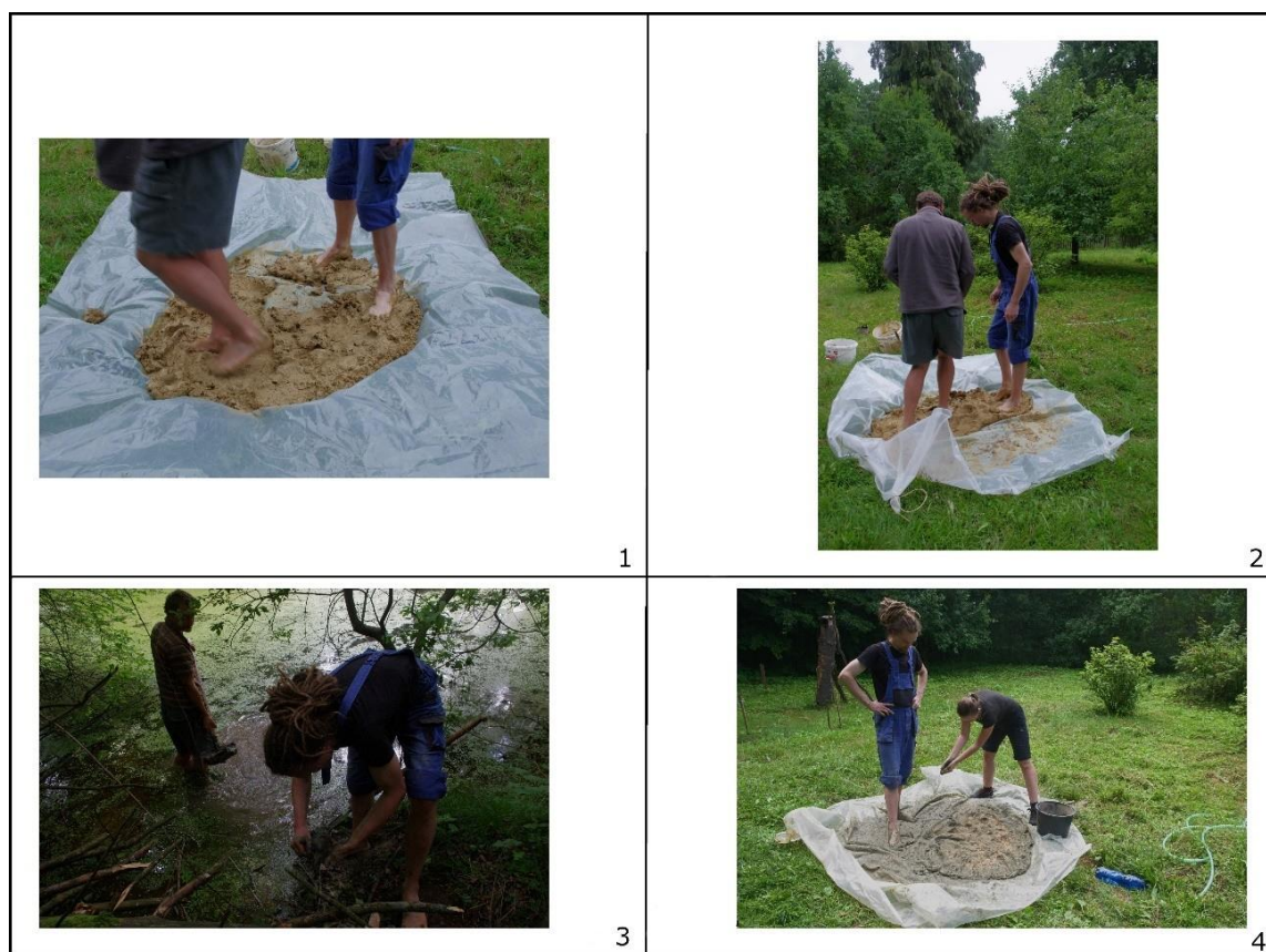
Obr. 13 Příprava materiálu. 13:1, 13:2 – hnětení materiálu prošlapáváním; 13:3 – těžení hlíny z rybníka; 13:4 – přidávání ostřiva (foto Markéta Augustýnová).
