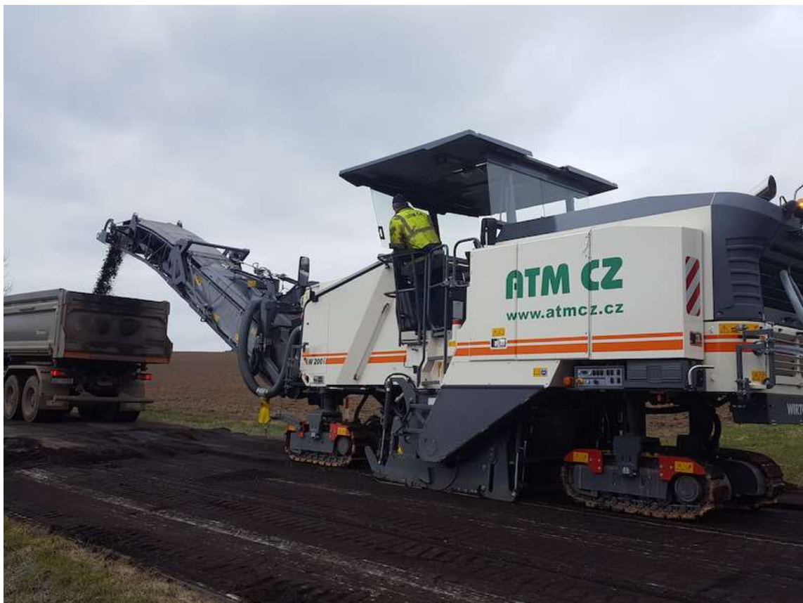
Obr. 1 Silniční fréza Wirtgen 2000/2400 [9]
