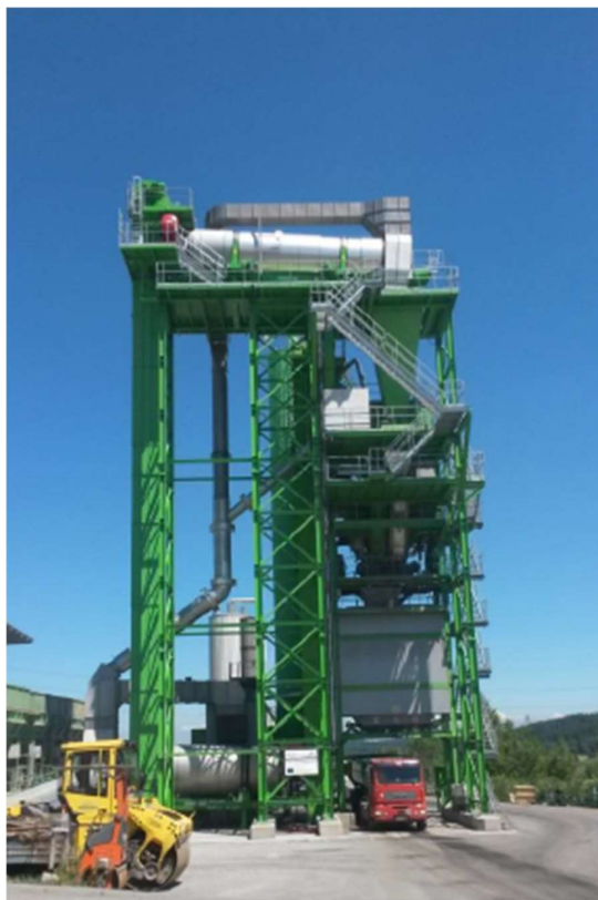
Obr. 14 Obalovna asfaltových směsí vybavena paralelním sušícím bubnem – Česká republika – Bruntál [19]
