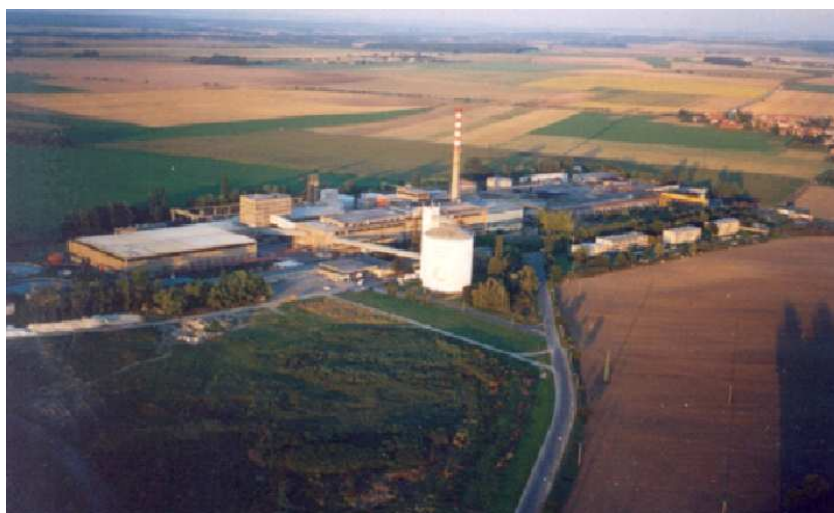
Obrázek č. 1 Cukrovar Hrochův Týnec před demolicí
