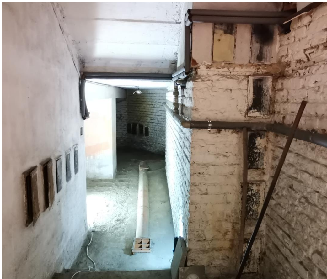
Obrázek 31: Částečně rekonstruovaná kanalizace
