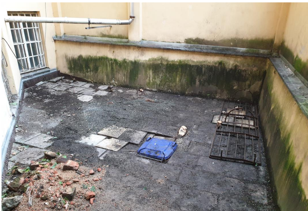
Obrázek 30: Nežádoucí hromadění vlhkosti ve dvoře [9]
