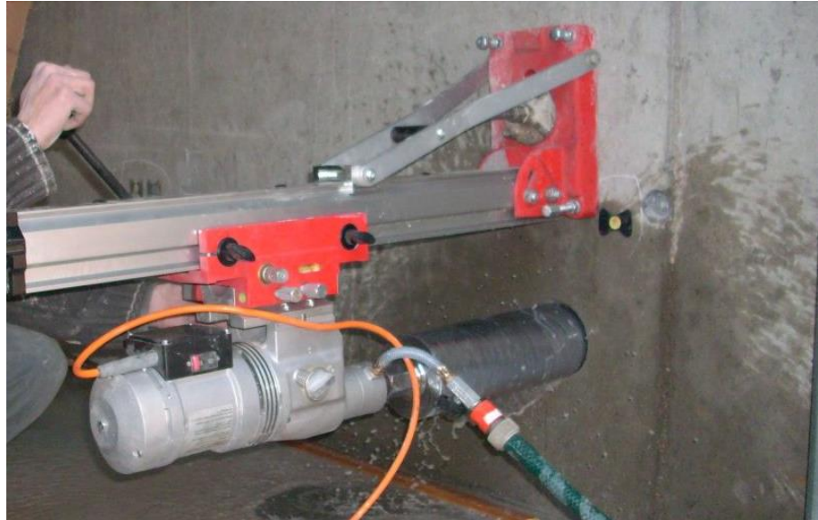
Obrázek 4: Odběr jádrového vývrtnu [7]
