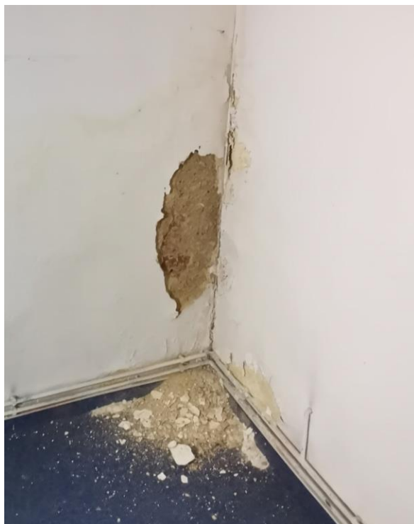
Obrázek 27: Vlhký kout v prostorách bývalé kuchyně
