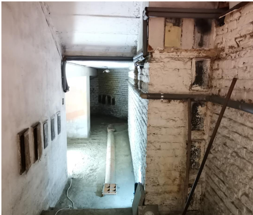
Obrázek 31: Částečně rekonstruovaná kanalizace
