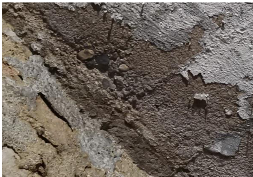
Obrázek 23: Viditelná struktura betonu stropní desky
