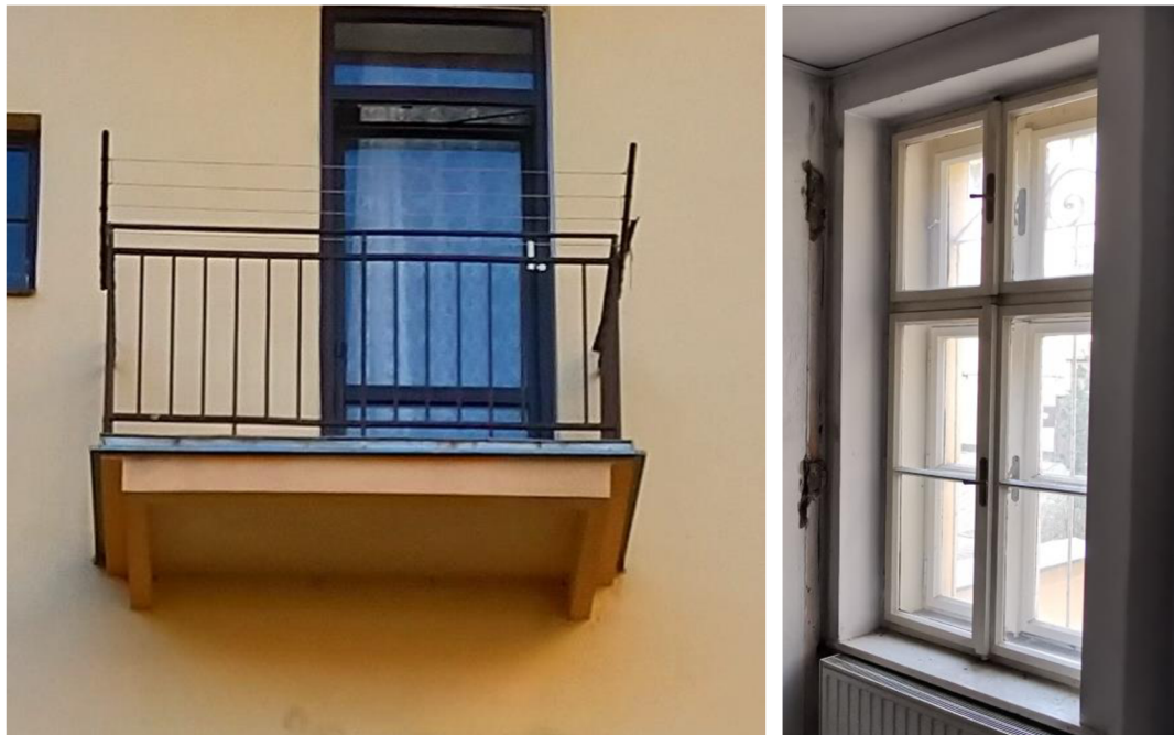
Obrázek 26: Konstrukce balkónu a původní výplně stavebních otvorů [9]
