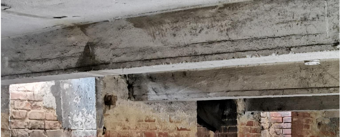
Obrázek 22: Betonové trámy se dochovaly ve velmi dobrém stavu
