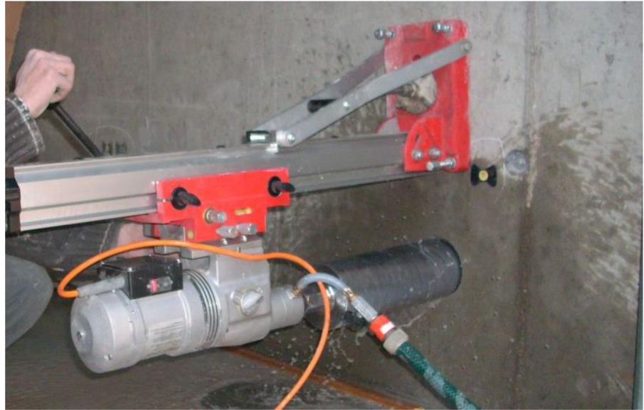
Obrázek 4: Odběr jádrového vývrtu [7]
