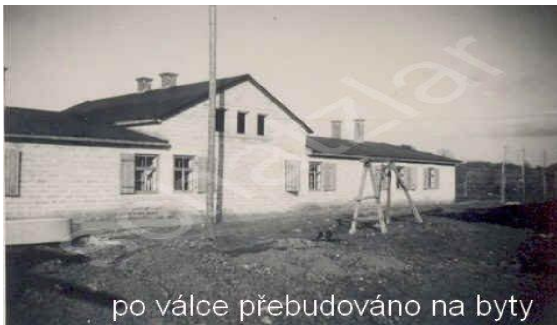
Obrázek 18 Po válce měly být dřevěné ubikace přebudovány na byty
