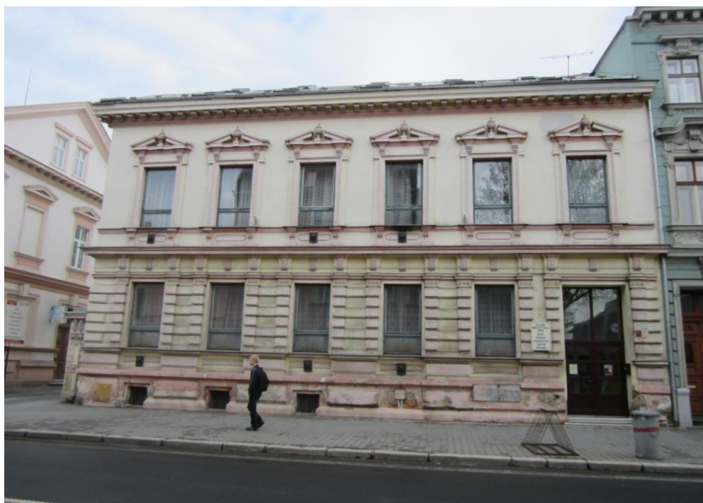
č. 2 Budova Základní umělecké školy Krnov, Revoluční ulice 18 (str. 41)
