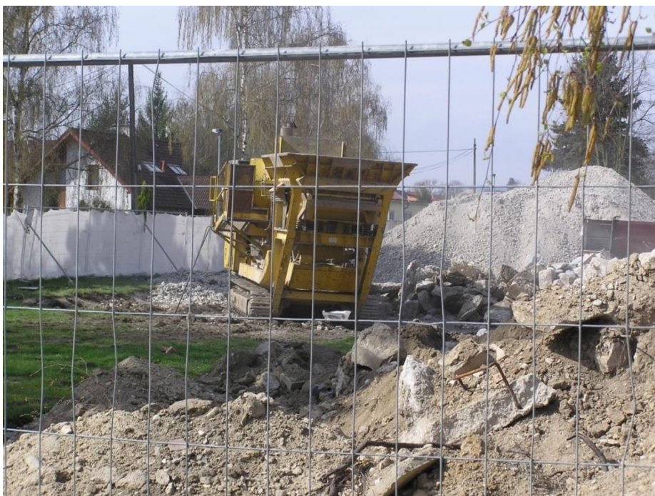
Obrázek 11 - Drcení demoličního odpadu [zdroj: autor]
