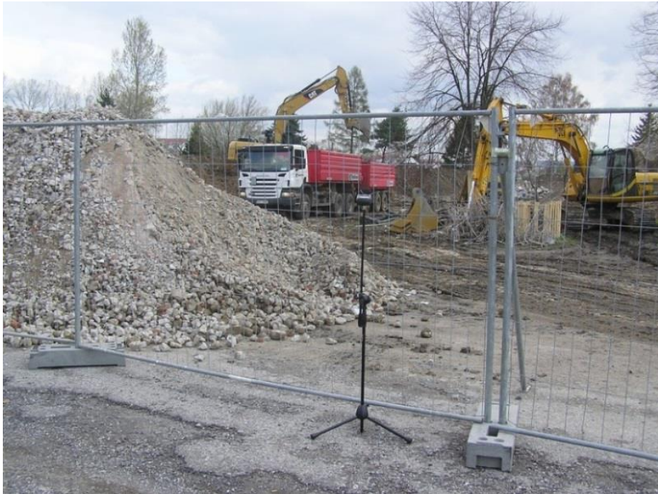
Obrázek 12 - Nakládání recyklátu [zdroj: autor]
