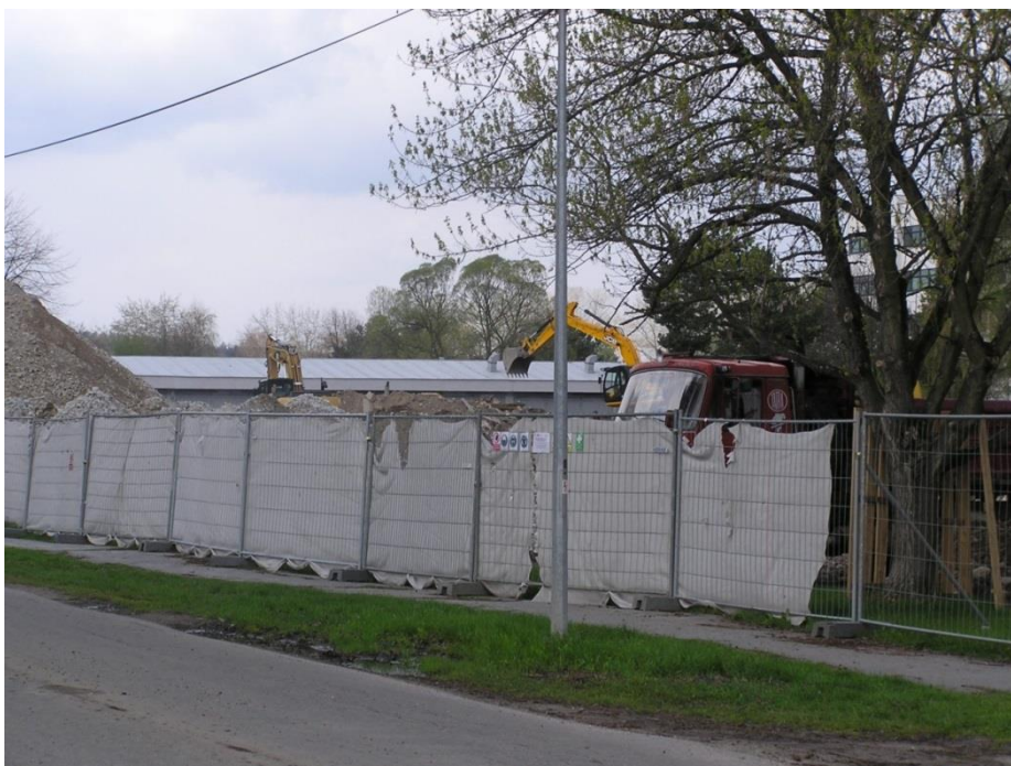
Obrázek 18 - Měření hlučnosti drcení a přeskupování demoličního odpadu u obytné zástavby
