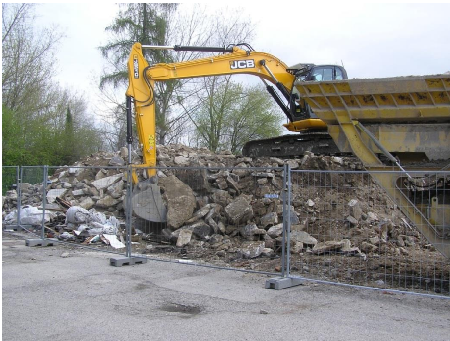
Obrázek 14 - Nakládání demoličního odpadu do drtiče [zdroj: autor]
