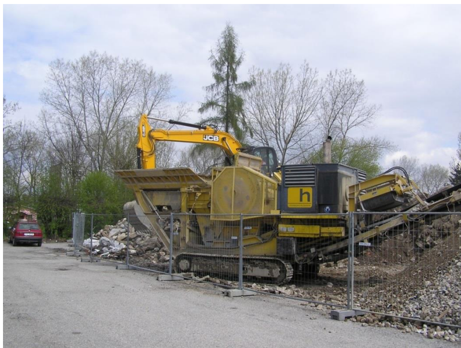
Obrázek 16 - Drcení demoličního odpadu [zdroj: autor]
