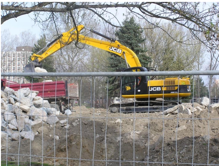
Obrázek 7 - Nakládání demoličního odpadu [zdroj: autor]
