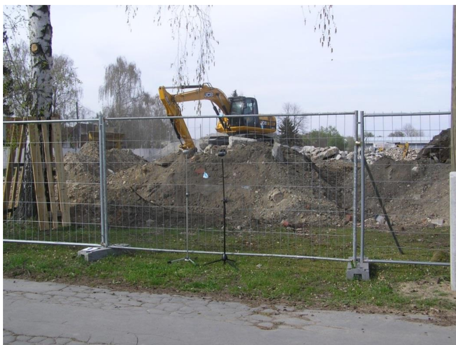
Obrázek 8 - Nakládání demoličního odpadu [zdroj: autor]
