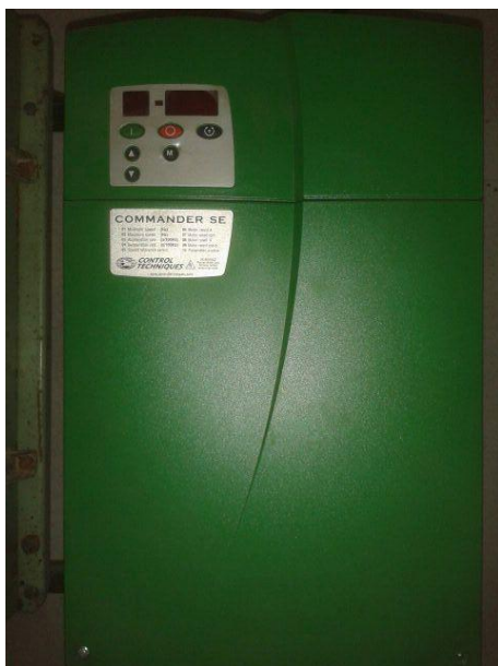
Obr. 9. Frekvenční měnič COMANDER SE TYP 43401500, archiv autora
