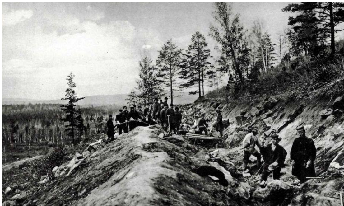
Příloha č. 17: Stavba Transsibiřské magistrály – kopání základů.
