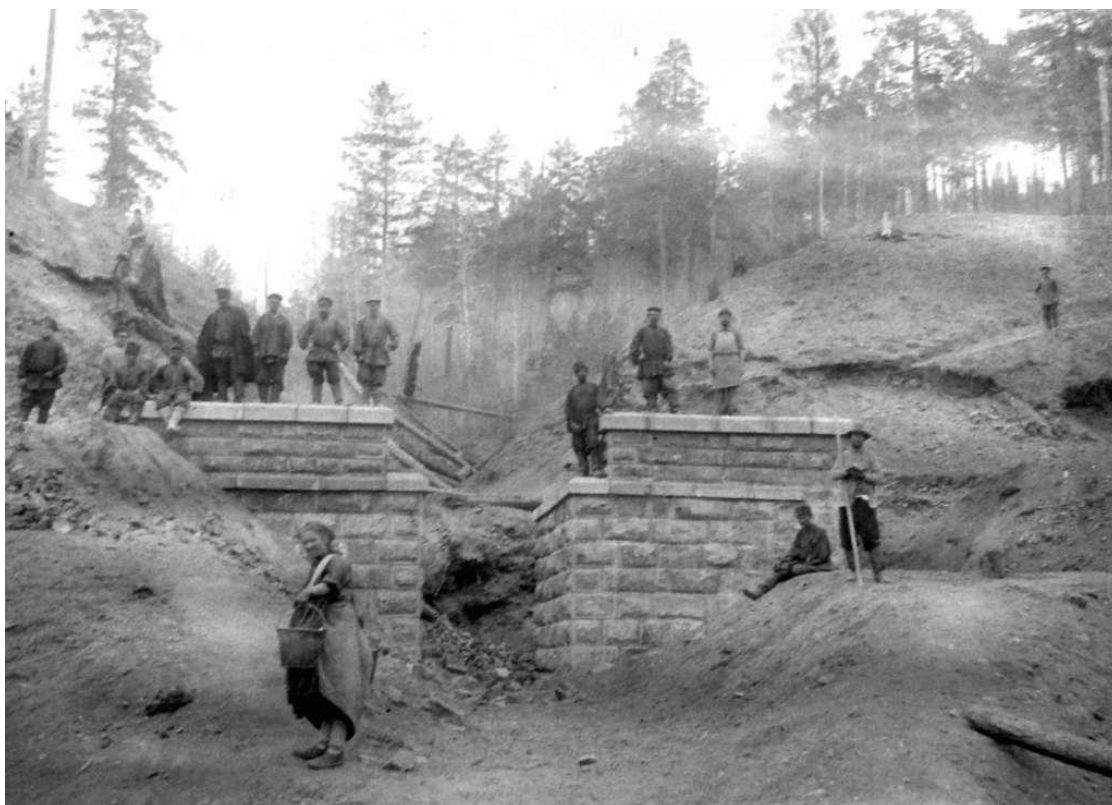
Příloha č. 15: Stavba kamenného mostu na Transsibu.
