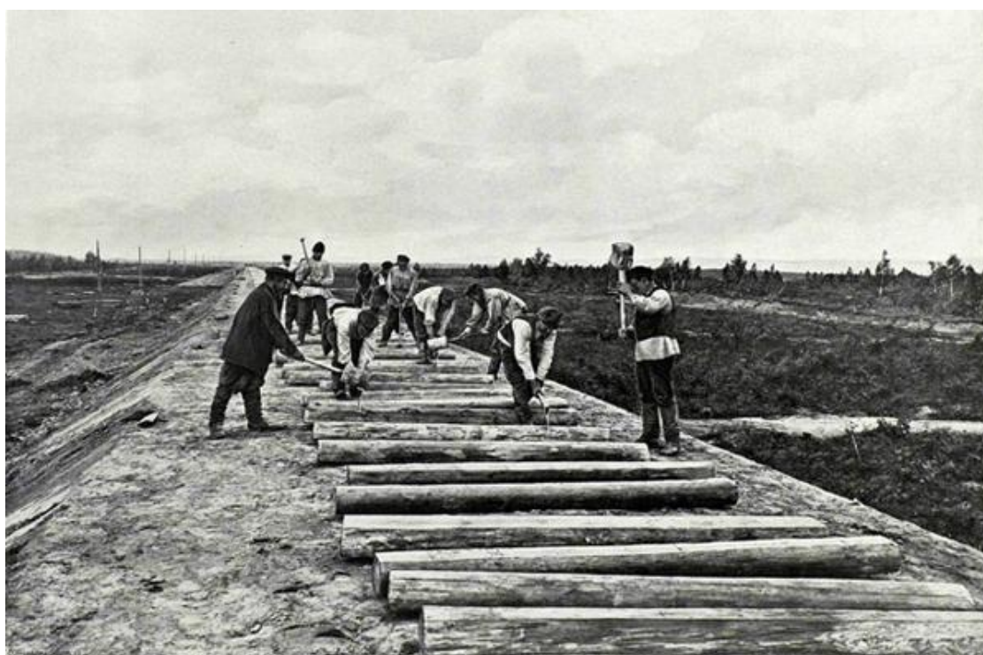
Příloha č. 14: Stavba Transsibiřské magistrály – pokládání pražců. Zdroj: http://pikabu.ru/tag/Транссибирская%20магистраль/
