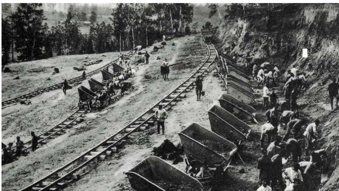
Příloha č. 16: Stavba Transsibiřské magistrály – kopání základů.
