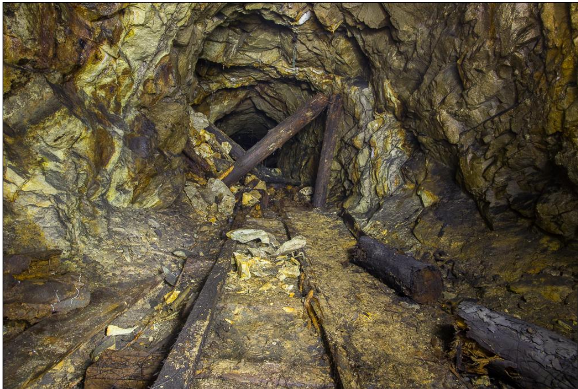
Пříloha č. 1 – Zbytky dřevěných kolejí
