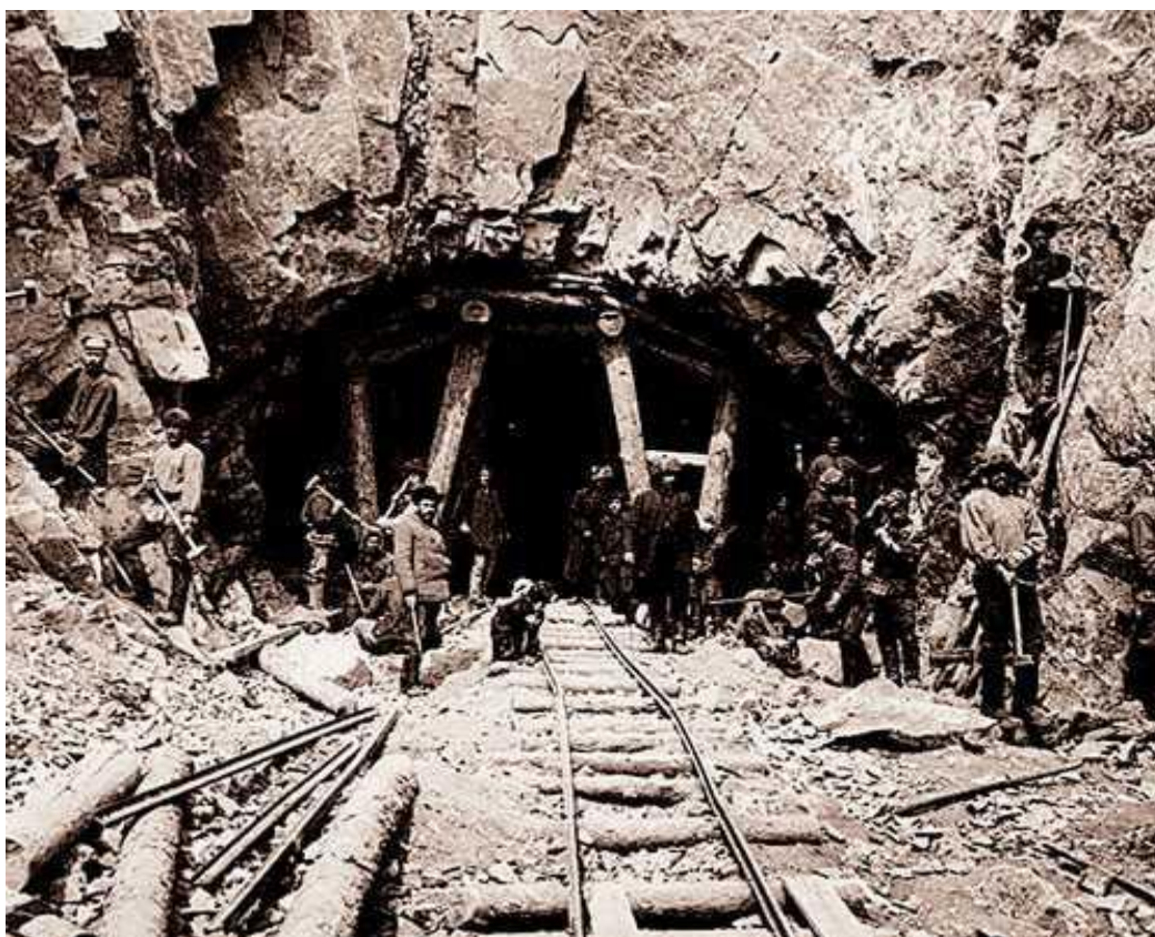
Příloha č. 34: Stavba tunelu – Krugobajkalka
