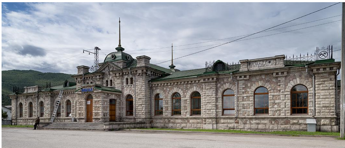
Obr. č. 40: železniční nádraží ve Sljud'jance (вокзал Слюдянка) 60
