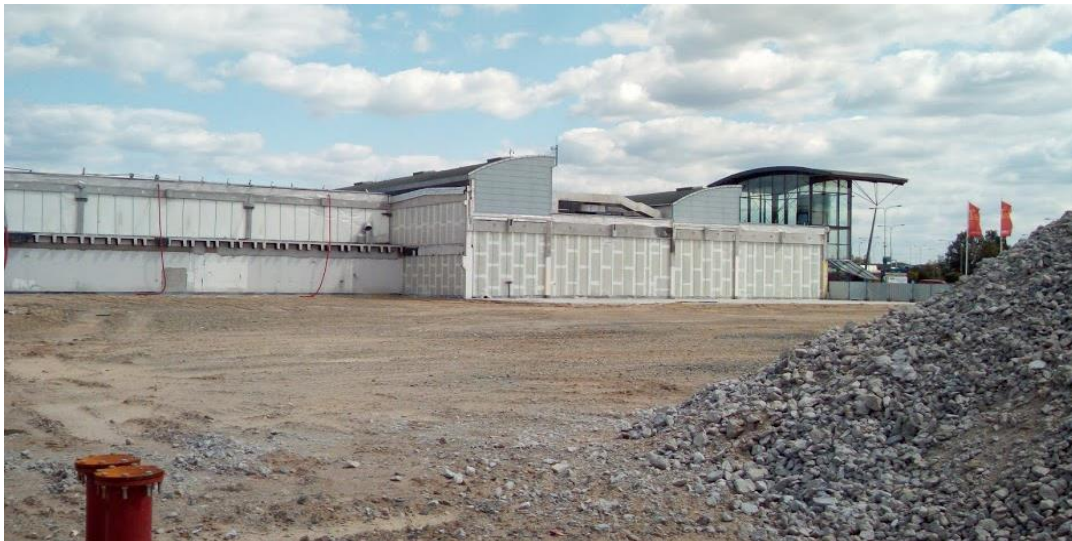
Obrázek 39: Pohled na staveniště po demolici části skeletu
