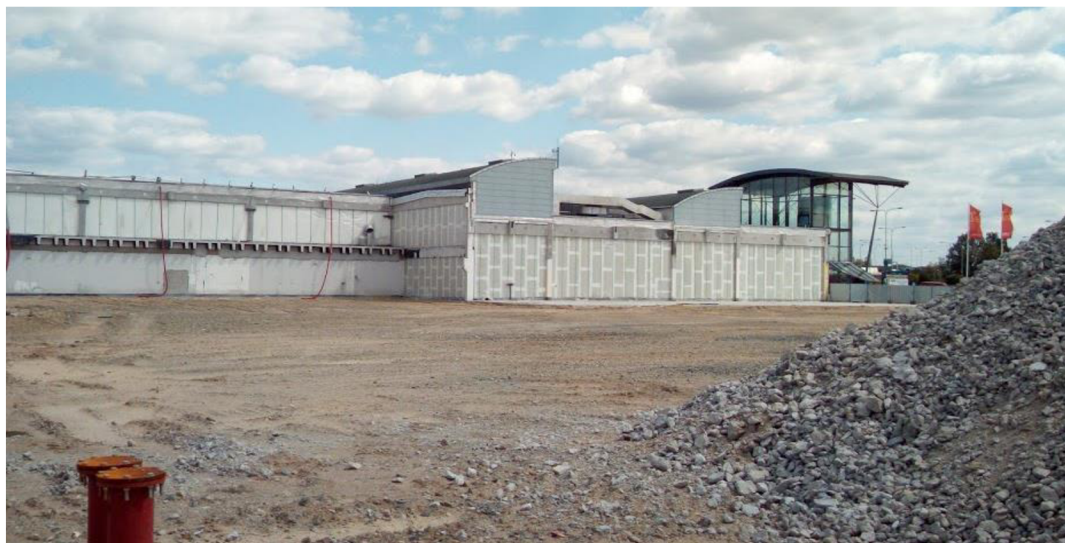
Obrázek 39: Pohled na staveniště po demolici části skeletu
