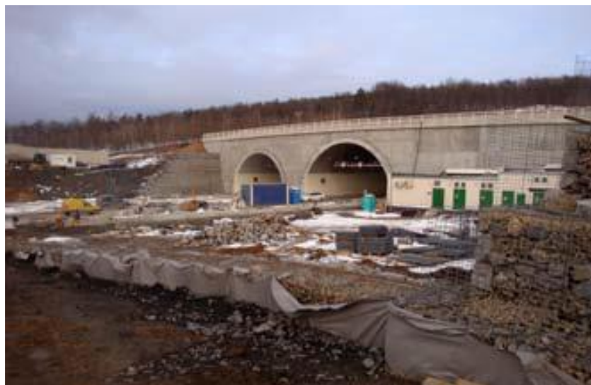
Obrázek 7: Stavba migračního tunelu (Anděl a kol. 2011)
