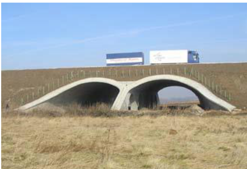
Obrázek 4: Přesypaný most (Anděl a kol. 2011)
