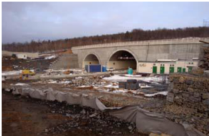
Obrázek 7: Stavba migračního tunelu (Anděl a kol. 2011)
