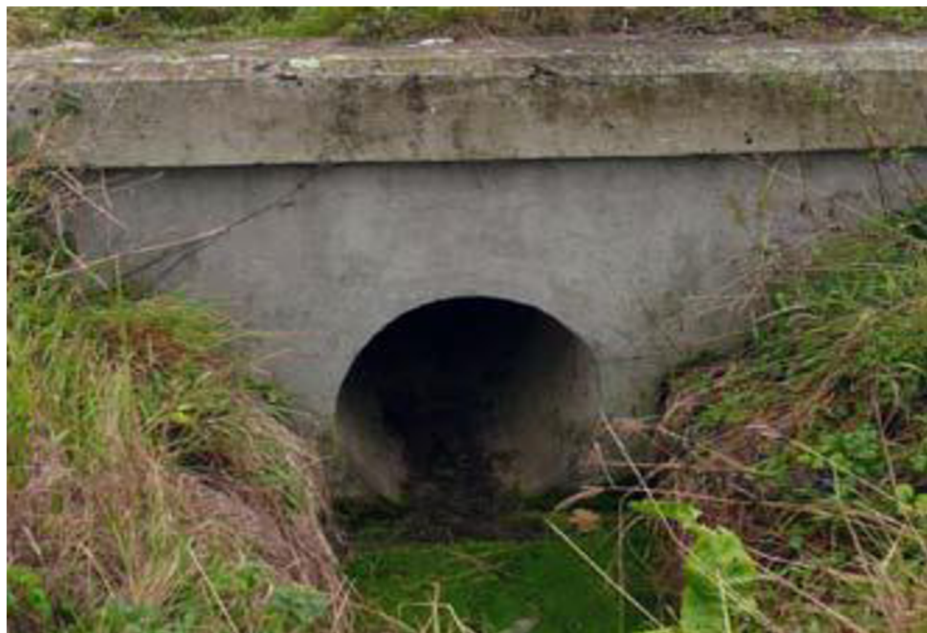
Obrázek 2: Propustek s kruhovým profilem (Anděl a kol. 2011)
