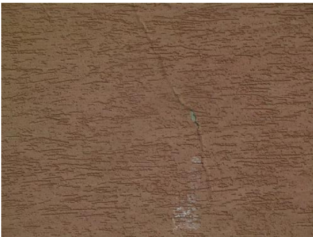
Obr. 19 Vliv nekvalitní penetrace, nesprávně provedené základní vrstvy a dle stop zasolení i nevhodného druhu použité omítky - vznik trhliny až do základní vrstvy a podstatné snížení životnosti a funkce systému [102]
