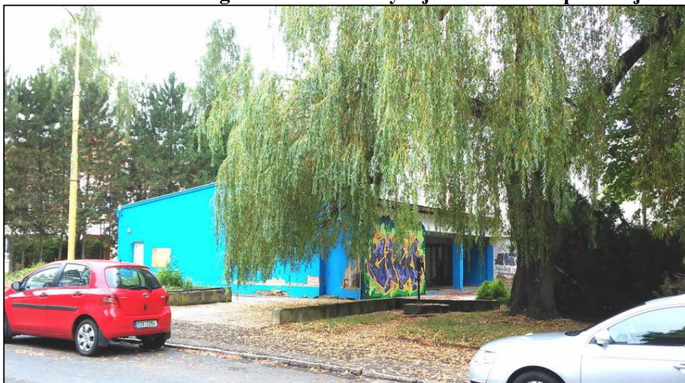
Obr. č. 13: Vzrostlá vegetace téměř zakrývající hlavní vstup do objektu
