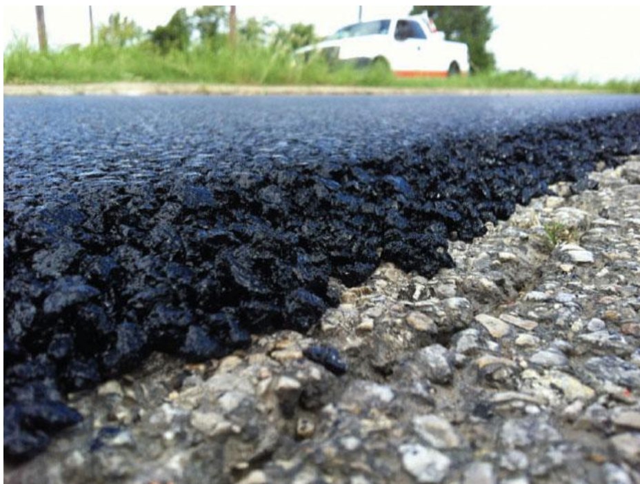
Obr. 10: Asfaltový koberec mastixový s přerušenu zrnitostí [22]
