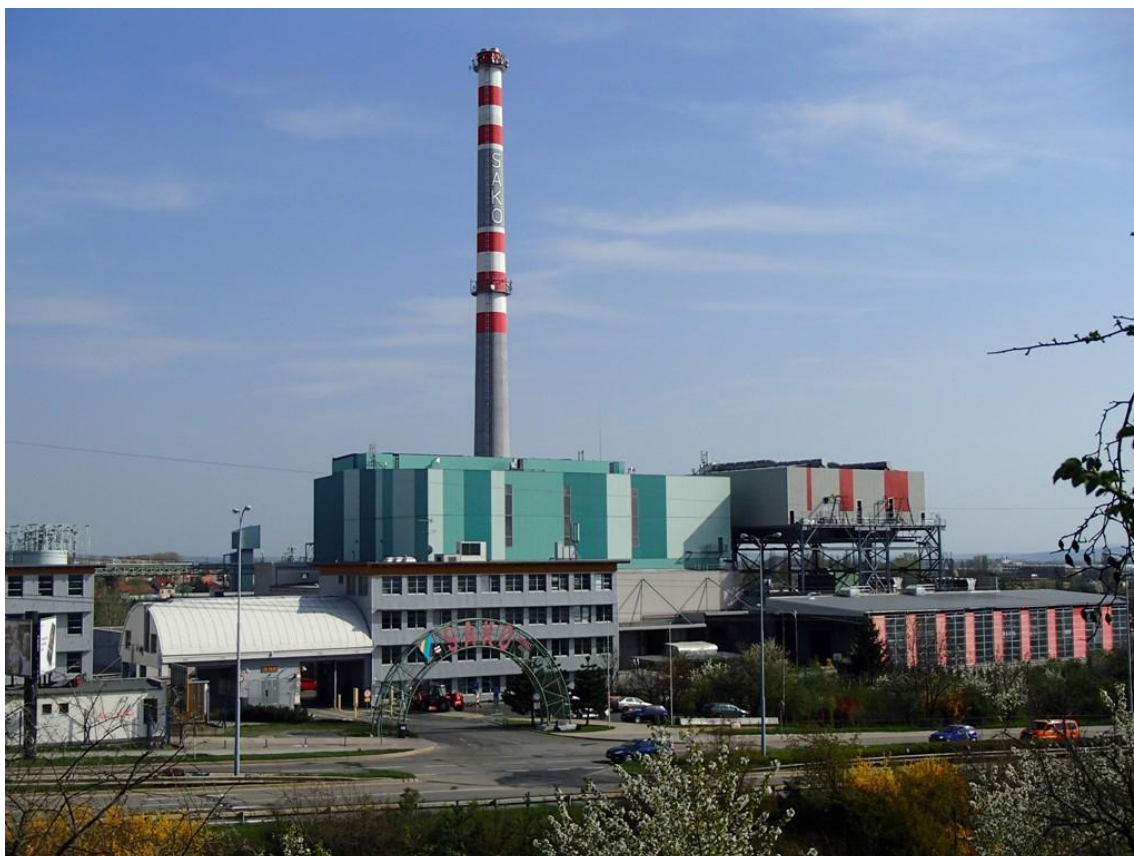
Obr. 6: Zařízení na energetické využívání odpadu společnosti SAKO Brno, a.s. [13]
