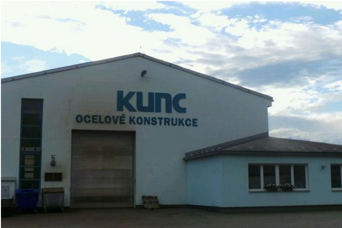
Obrázek 7: Kunc – ocelové konstrukce (příprava)
