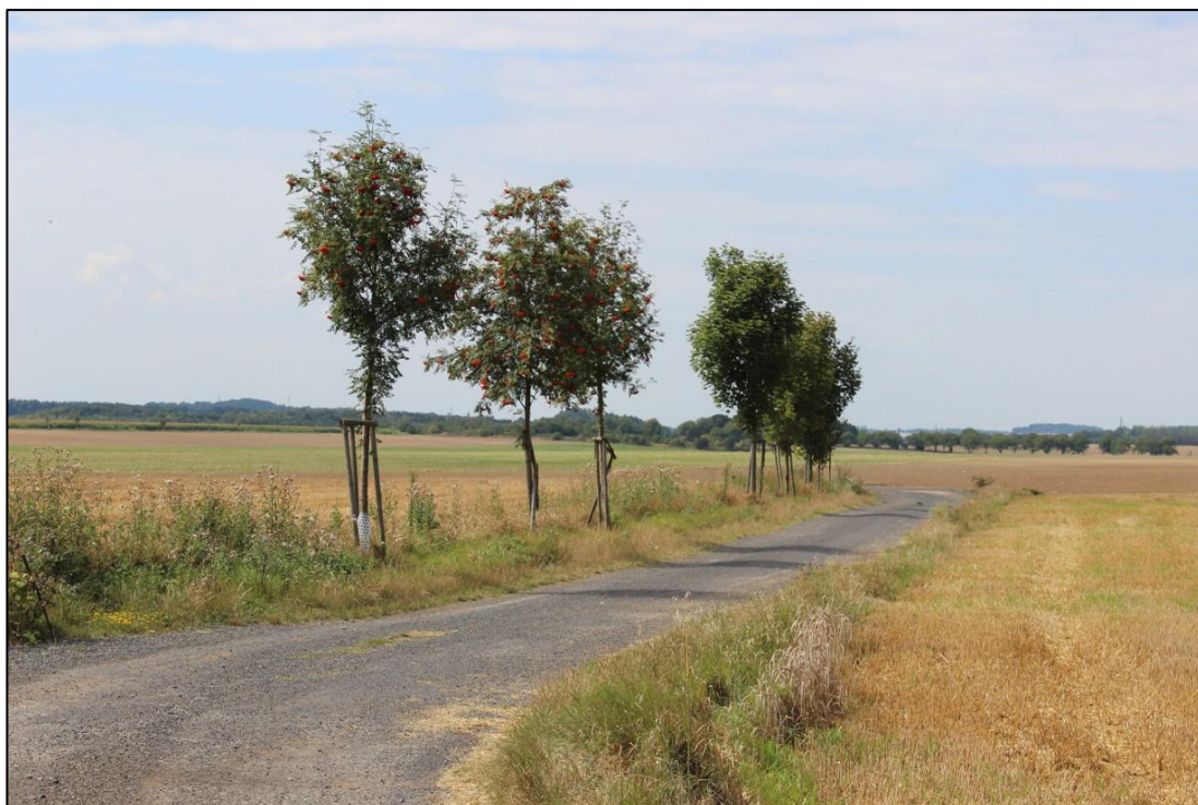
Foto č. 7 - Realizovaná cesta C6 (Tůmová, srpen 2014)
