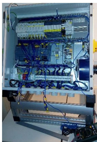
Obrázek 42 - Realizace zapojování součástí
