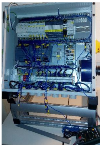
Obrázek 42 - Realizace zapojování součástí
