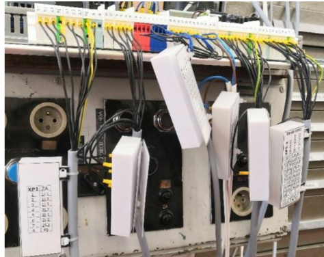
Obrázek 43 - Izolační přípravky a převodní tabulky
