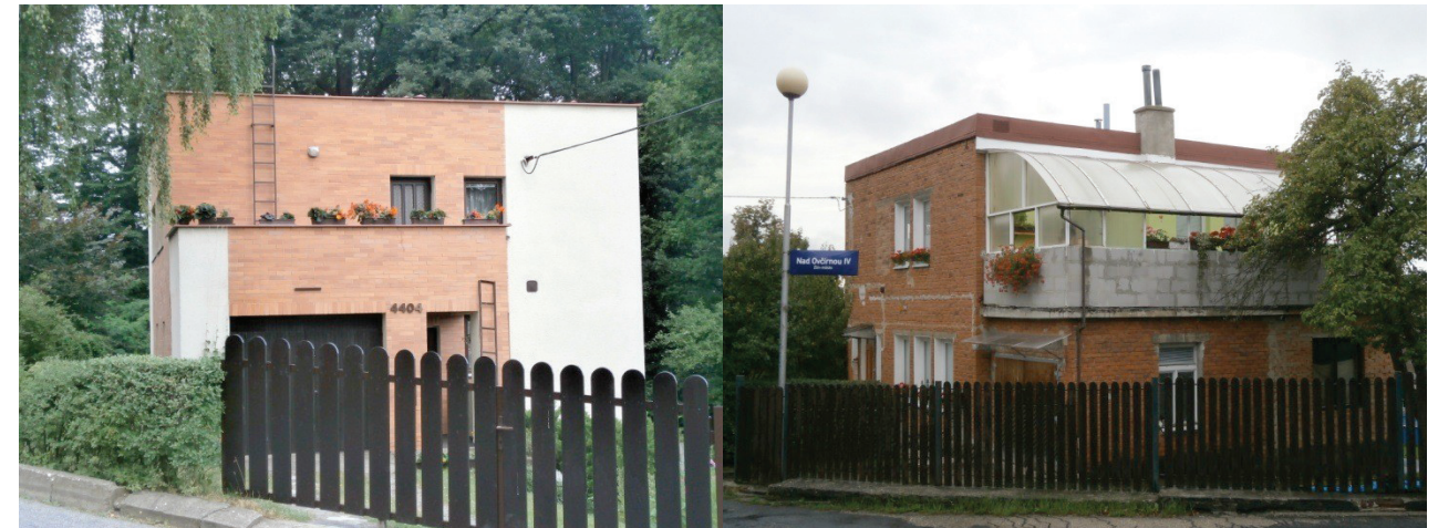
Obr. č. 61: Kombinace cihlového obkladu s jemně oranžovou omítkou, domek ztrácí původní podobu
