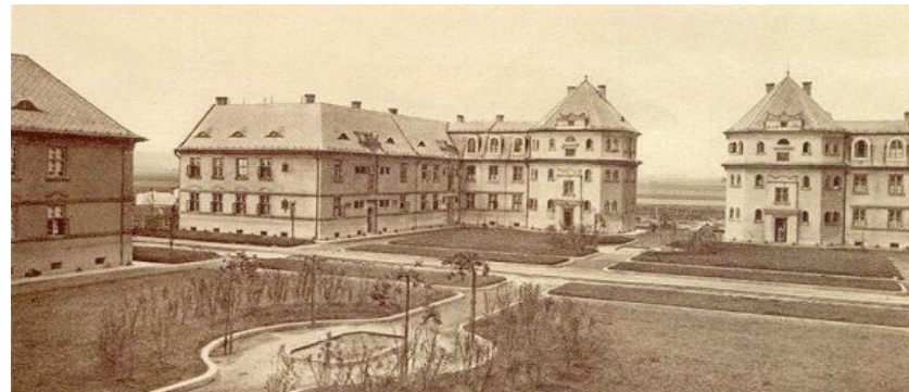
Obr. č. 49: Pohled z půlkruhového náměstí
