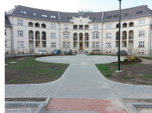
Obr. č. 52: Nově vybudované půlkruhové náměstí
