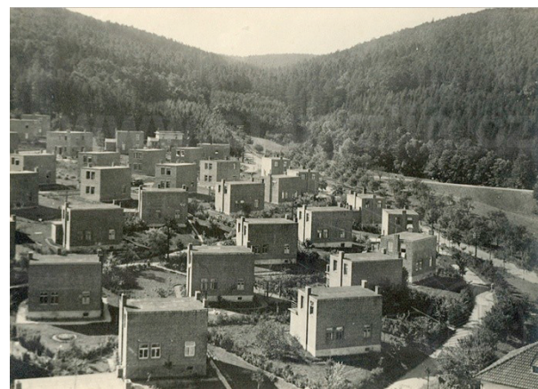
Obr. č. 60: Obytná čtvrť Letná, úprava zahrad
