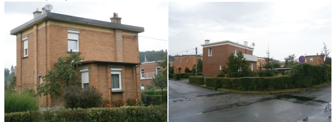
Obr. č. 65: Drobná rekonstrukce domku
