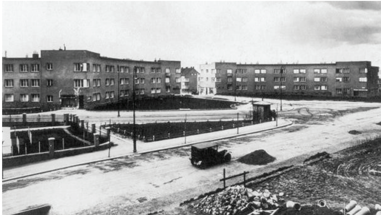
Obr. č. 119: Pohled na původní stav nájemních domů a Vaňkovo náměstí
