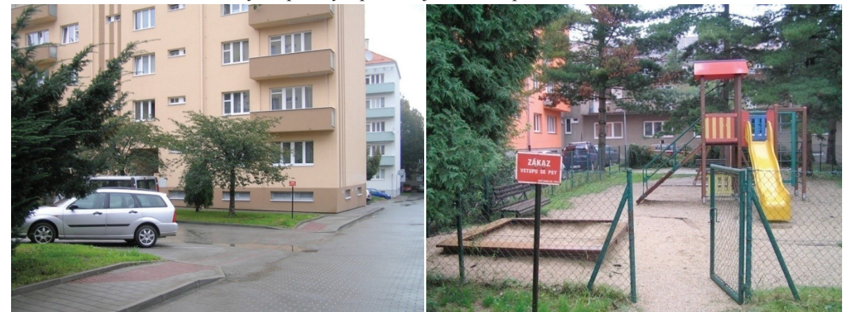
Obr. č. 108: Pohled na část obytného prostoru, s použitím zámkové dlažby
