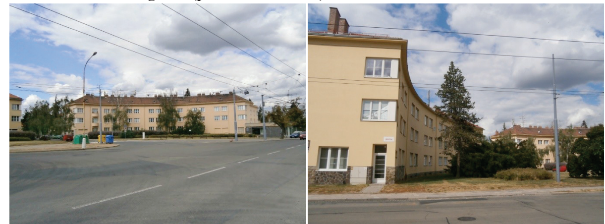
Obr. č. 123: Stav Vaňkovo náměstí před rekonstrukcí
