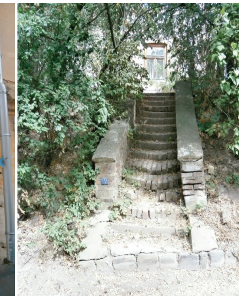
Obr. č. 44: Staré schodiště
