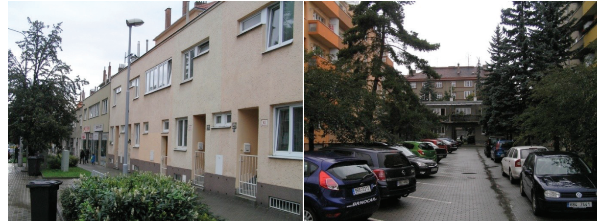
Obr. č. 106: Pohled na příčný jednopatrový trakt
