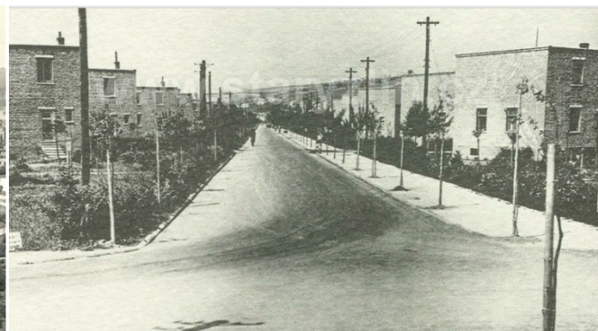
Obr. č. 59: Kolonie Zálešná - nová výsadba stromořadí
