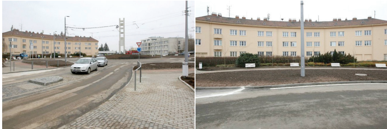
Obr. č. 127: Vaňkovo náměstí těsně po rekonstrukci
