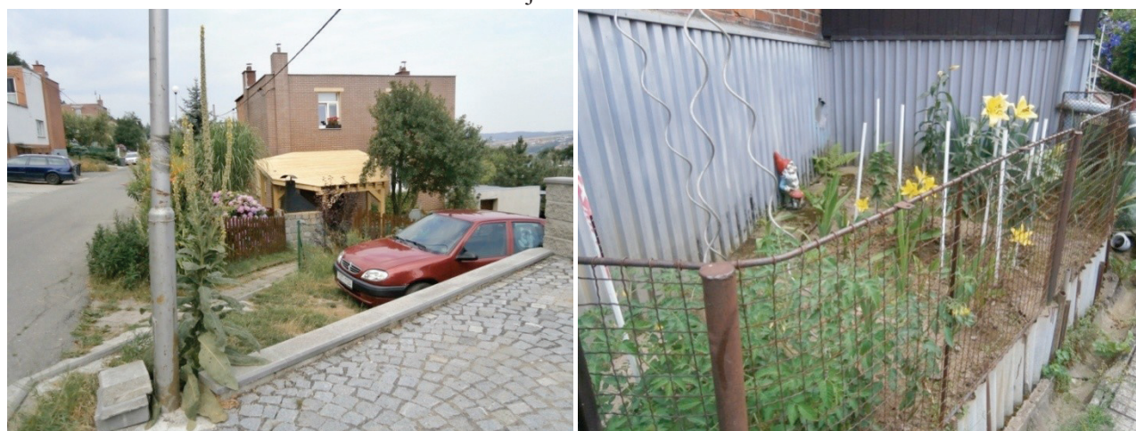
Obr. č. 80: Nevhodný přístřešek u hlavních dveří, který slouží jako pergola
