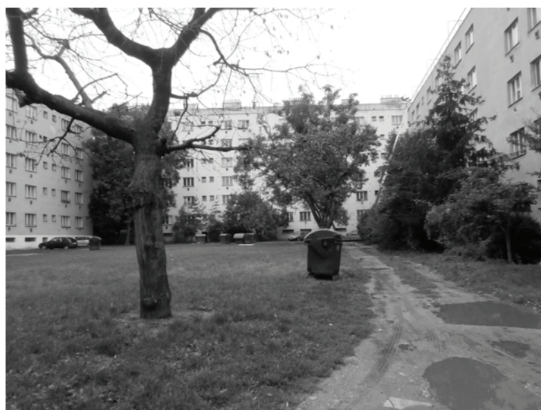
Obr. č. 19: Současný stav vnitrobloku
