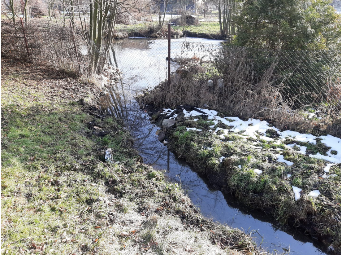
Příloha 12: svedení potoka na soukromý pozemek [37]
