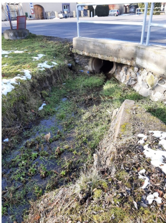
Příloha 10: Zbrašínský potok, jižní konec obce [37]
