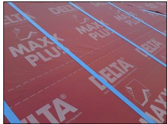
Obrázek [31]: Těsnící páska pod kontralatě
