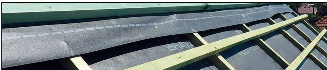
Obrázek [34]: Podstřešní fólie - překrytí hřebene
