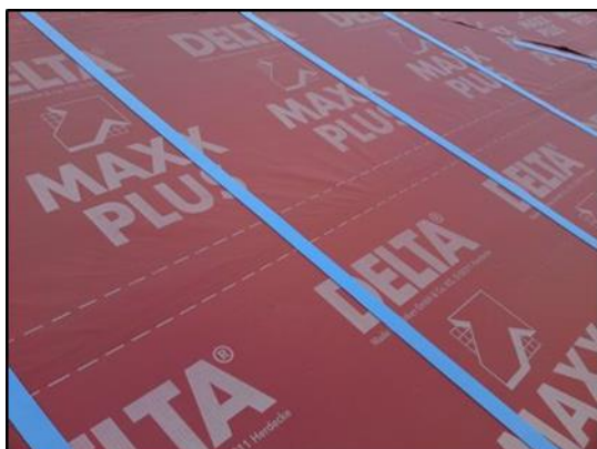
Obrázek [37]: Těsnící páska pod kontralatě
