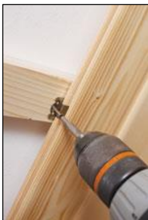
Obrázek [59]: Obkladové palubky - příponky
