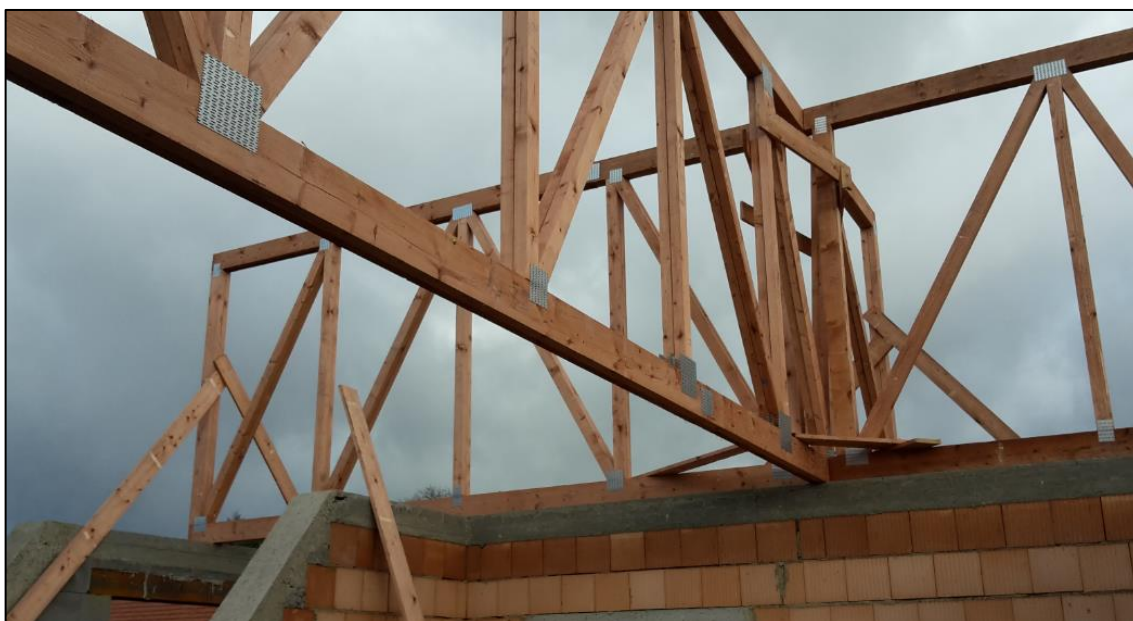
Obrázek [12]: Vazníky F1 až F8 - zavětrování
