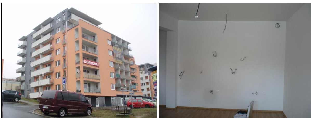
Obr. č. 17 - Bytová jednotka č. 6
