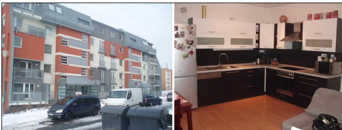
Obr. č. 23 - Bytová jednotka č. 9
