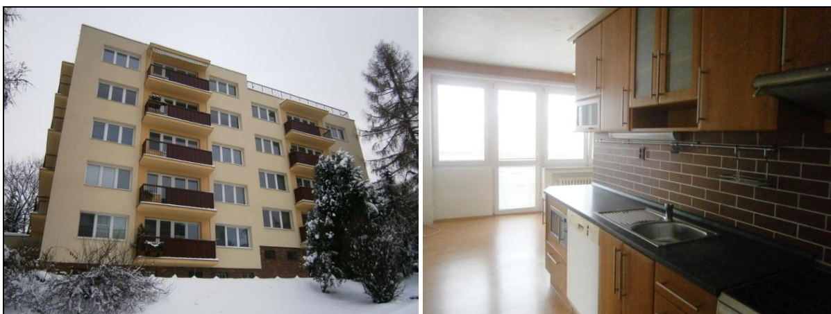
Obr. č. 25 - Bytová jednotka č. 10
