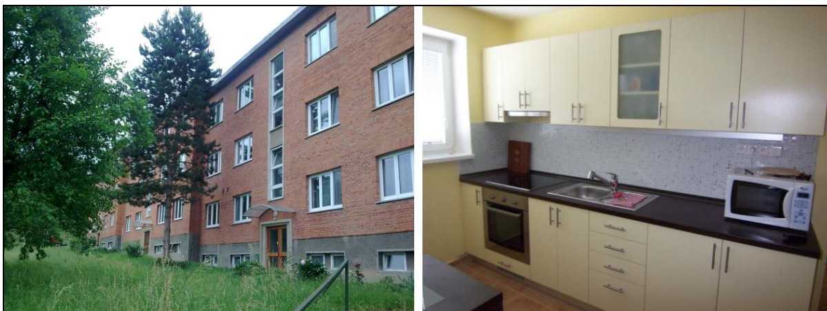
Obr. č. 19 - Bytová jednotka č. 7
