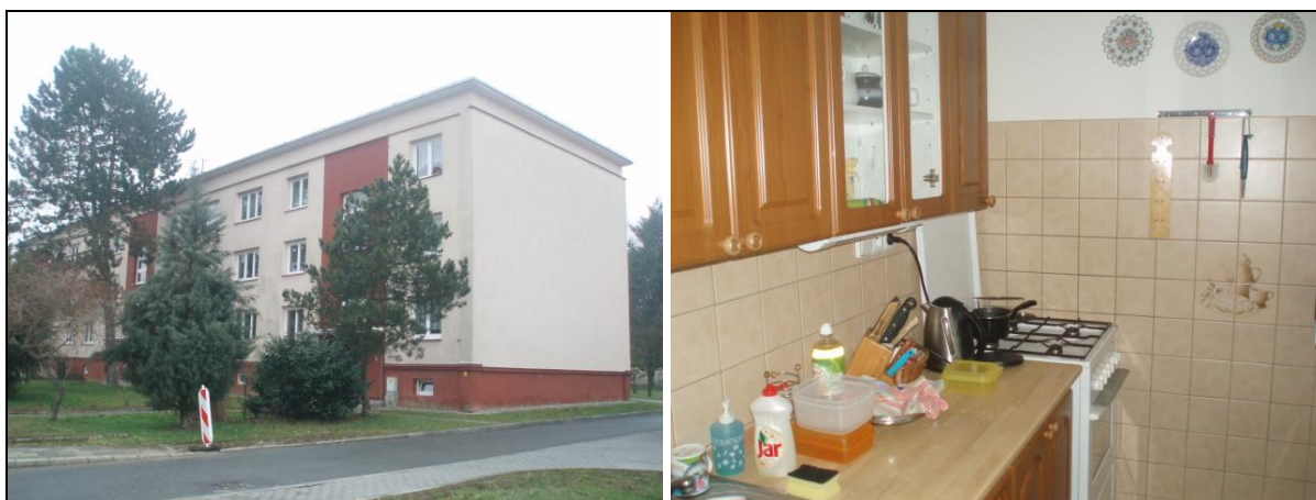
Obr. č. 15 - Bytová jednotka č. 5
