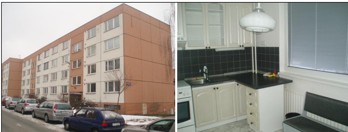
Obr. č. 21 - Bytová jednotka č. 8
