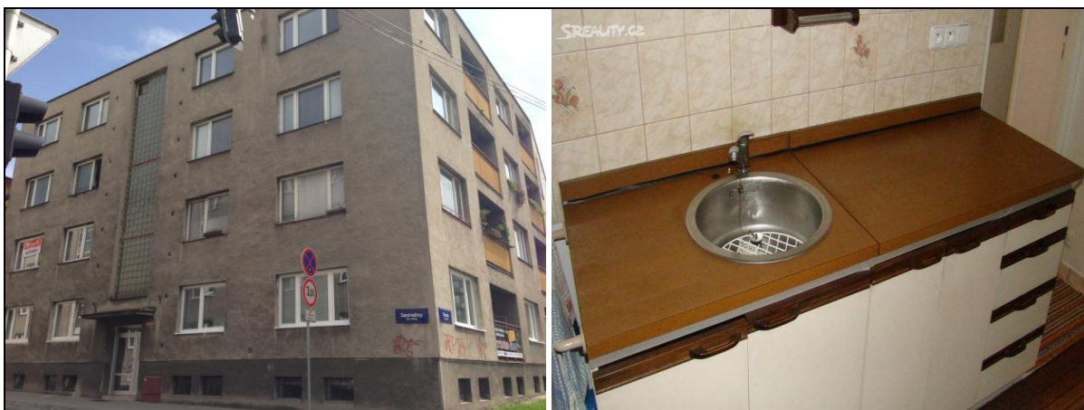
Obr. č. 13 – Bytová jednotka č. 4
