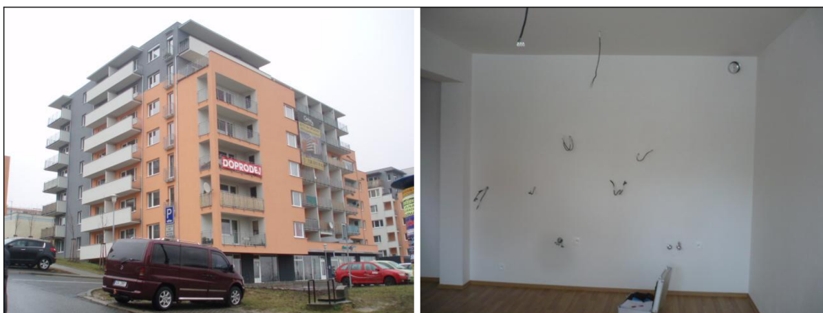
Obr. č. 17 - Bytová jednotka č. 6
