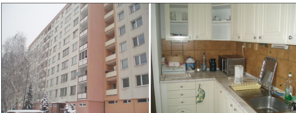
Obr. č. 27 - Bytová jednotka č. 11
