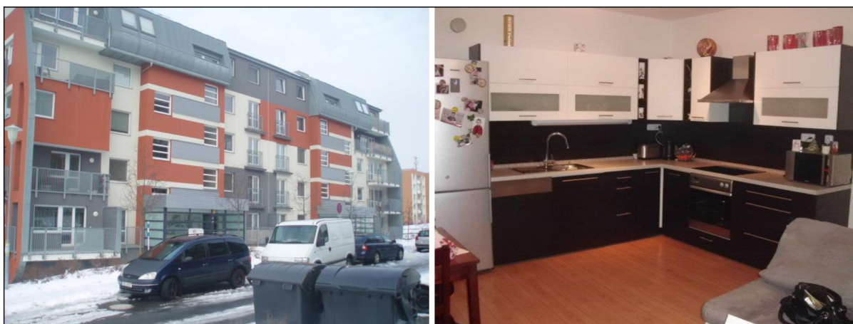
Obr. č. 23 - Bytová jednotka č. 9
