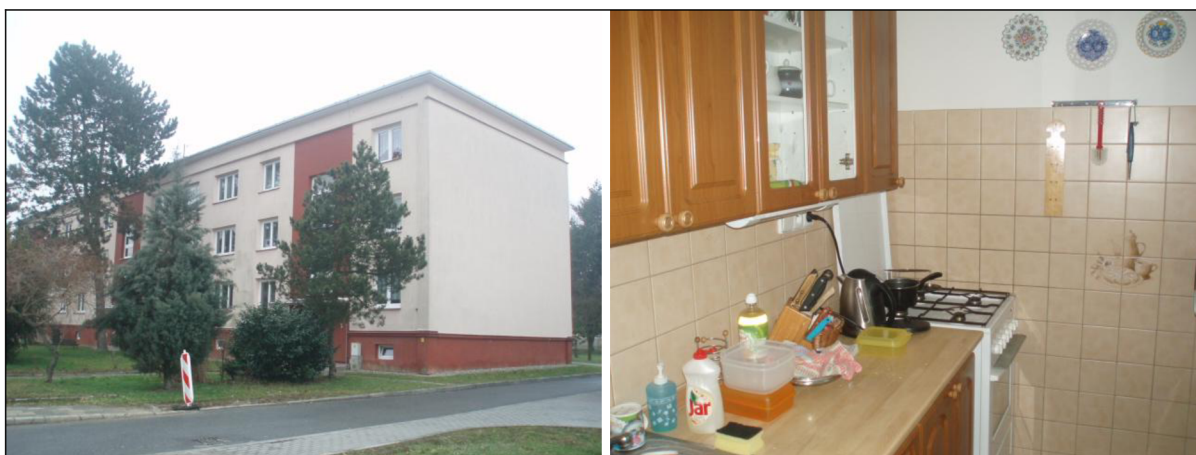
Obr. č. 15 - Bytová jednotka č. 5
