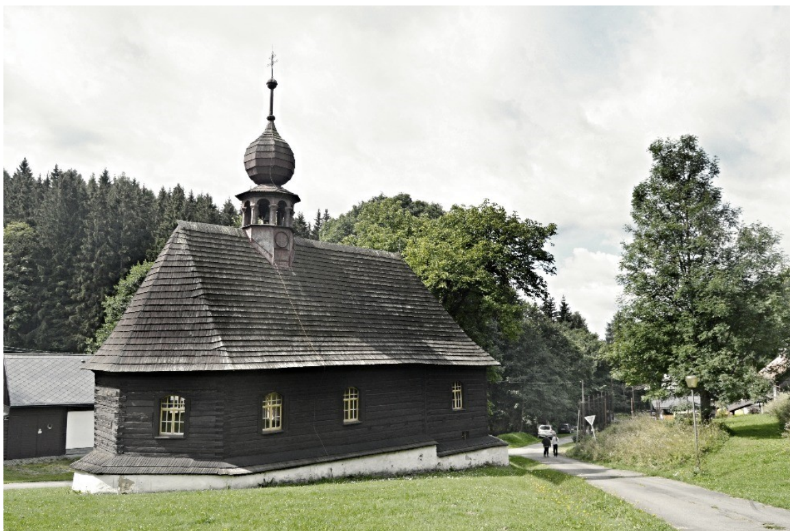
Obr. 8 Dřevěný kostel Klepáčov (zdroj: Tomáš Nečas, 2016)
