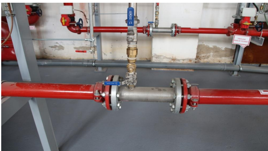
Obrázek 6 Přiměšovač ejektorového typu, zdroj: foto autor
