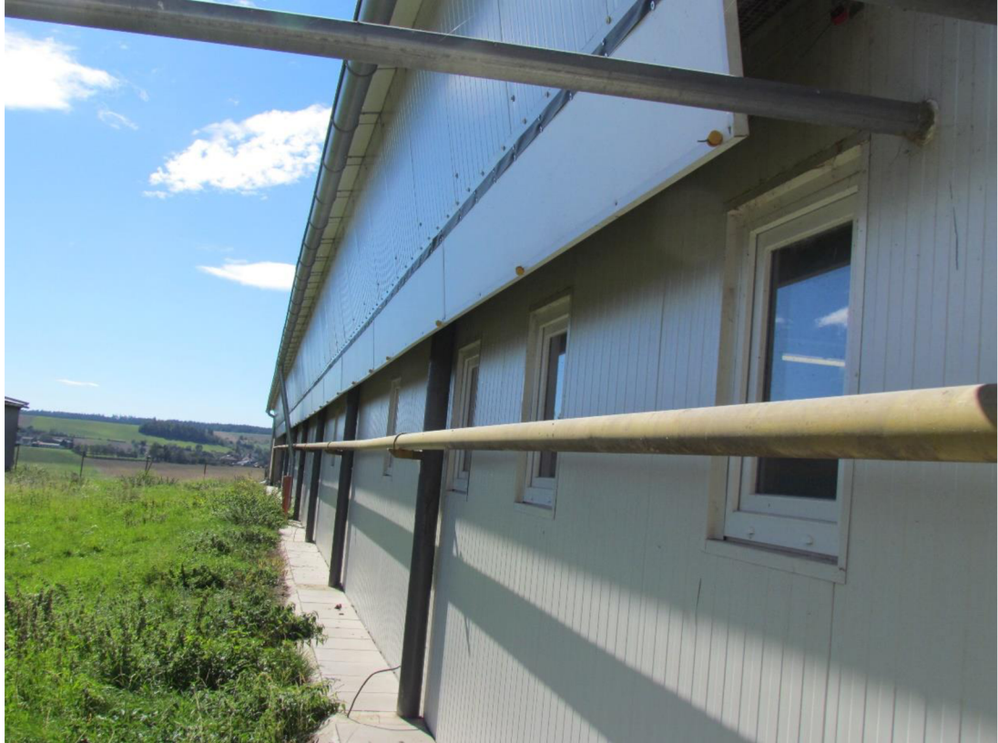
Obrázek 3.8: Venkovní ventilace vedená přes střechu do haly
