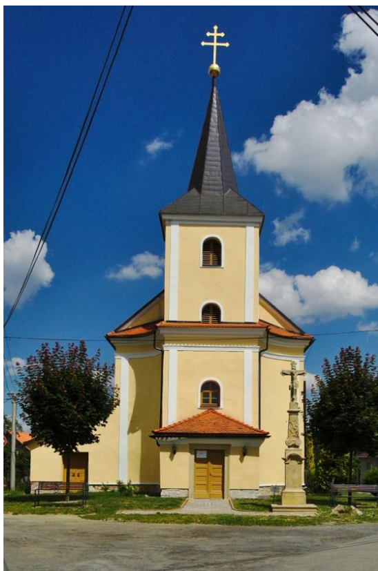
Příloha č. 83: Fotografie farního kostela Bolestné Panny Marie na Šubířově. 590
