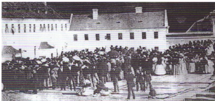
Pokládání základního kamene 16. 7. 1876 (Foto převzato z: Sto třicet let školy v Novém Městě na Moravě . Vyd. 1. Nové Město na Moravě, 2010, s. 11)
