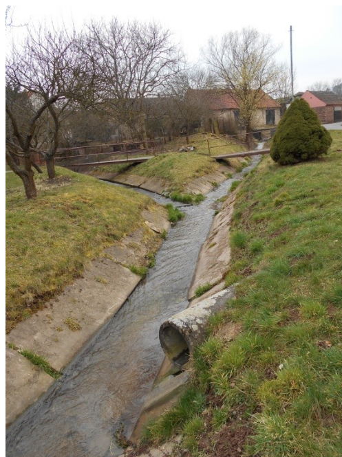
Obrázek 15 Betonové koryto v obci Sebranice, přítok a ústí odpadní voda, datum pořízení fotografie: 29. březen 2015
