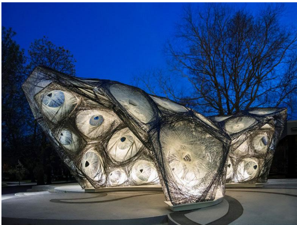
Obr. 10 Experimentální pavilon bionického výzkumu ze ztužených polymerů © ICD / ITKE University of Stuttgart
