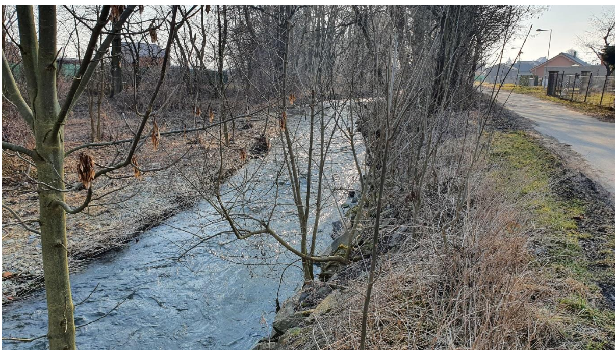
Foto č. 6: Pohled na Sítku v Lužicích, pravý břeh zpevněn hrubým balvanovým záhozem, levý břeh otevřený v širší inundační prostor (Zdroj: Vlastní archiv)
