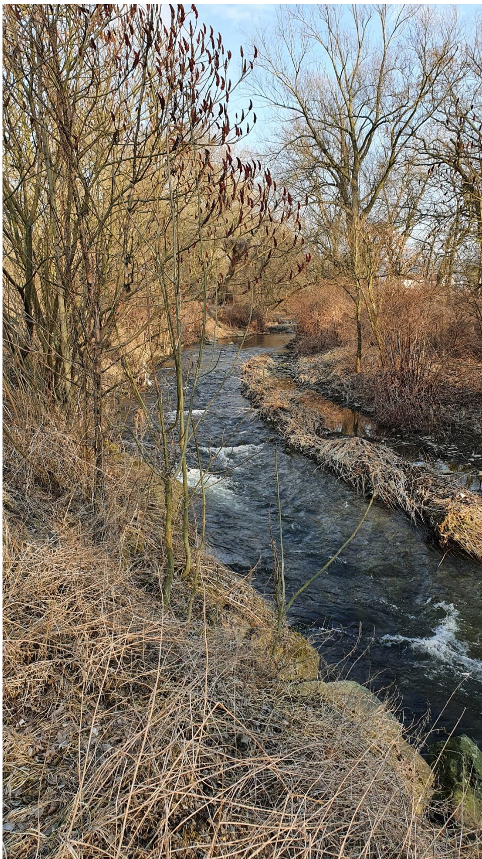
Foto č. 7: Opačný pohled na Sítku v Lužicích směrem od Šternberka, levý břeh zpevněn hrubým balvanovým záhozem, pravý břeh otevřený v širší inundační prostor, řeka má tendenci i v takto omezeném prostoru meandrovat (Zdroj: Vlastní archiv)
