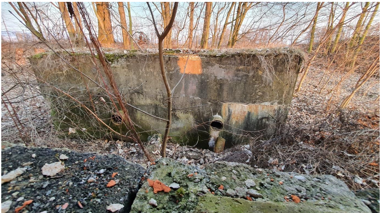
Foto č. 22: Odběrový žlab vody pro čerpání do závlahového potrubí (Zdroj: Vlastní archiv)
