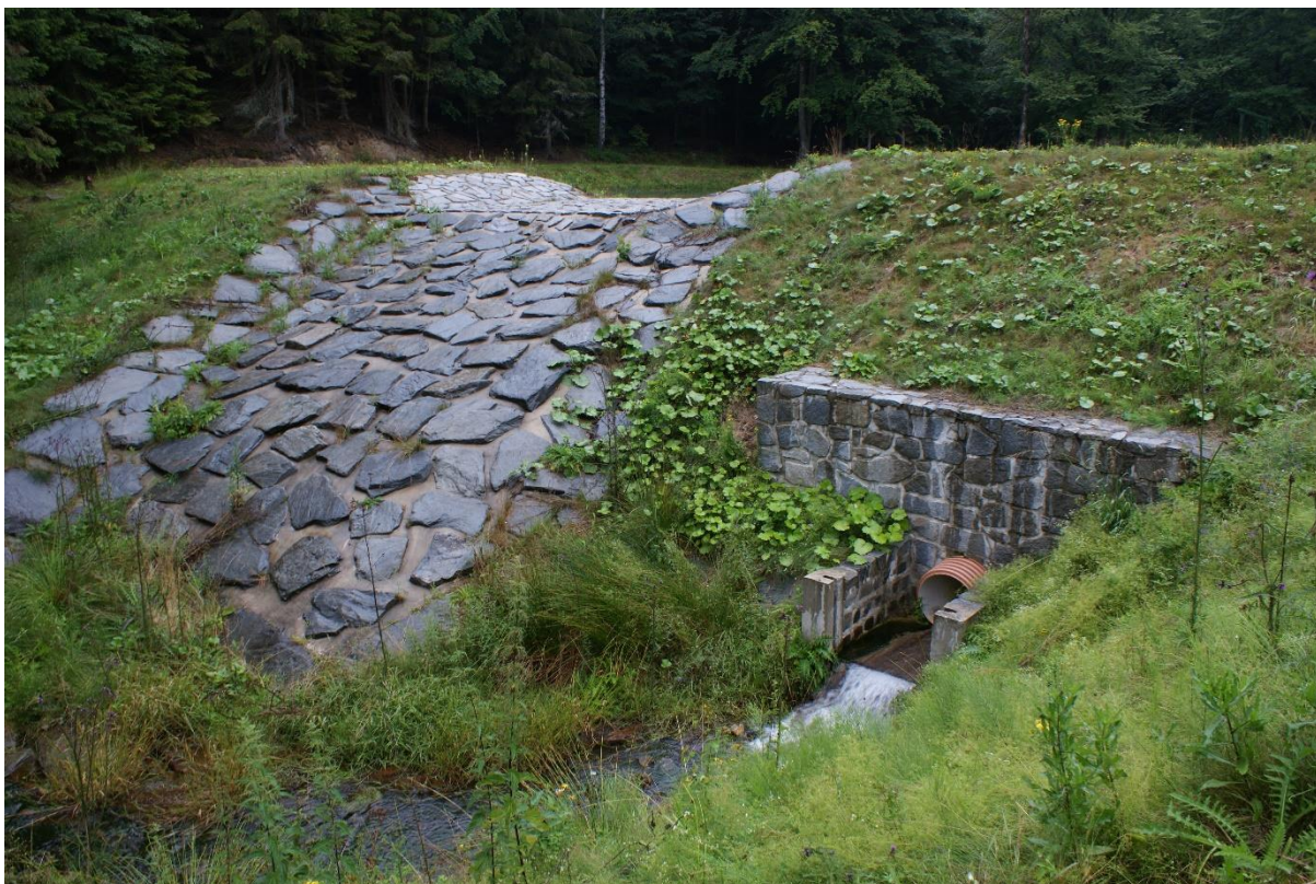
Foto č. 2: Čelní hráz zdýmacího objektu typu Kameňák na horním toku řeky Oskavy v CHKO Jeseník (Zdroj: Vlastní archiv)
