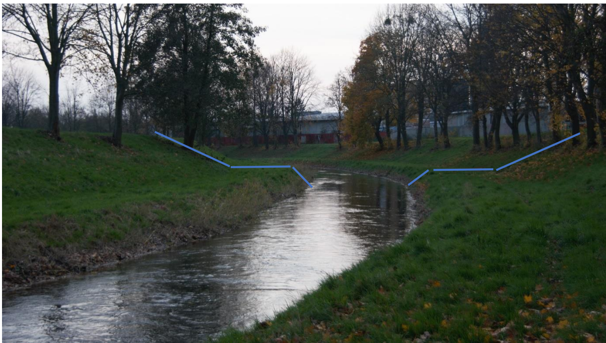
Foto č. 1: Modrou linií zvýrazněné lichoběžníkové koryto v intravilánu města Uničova (Zdroj: Vlastní archiv)
