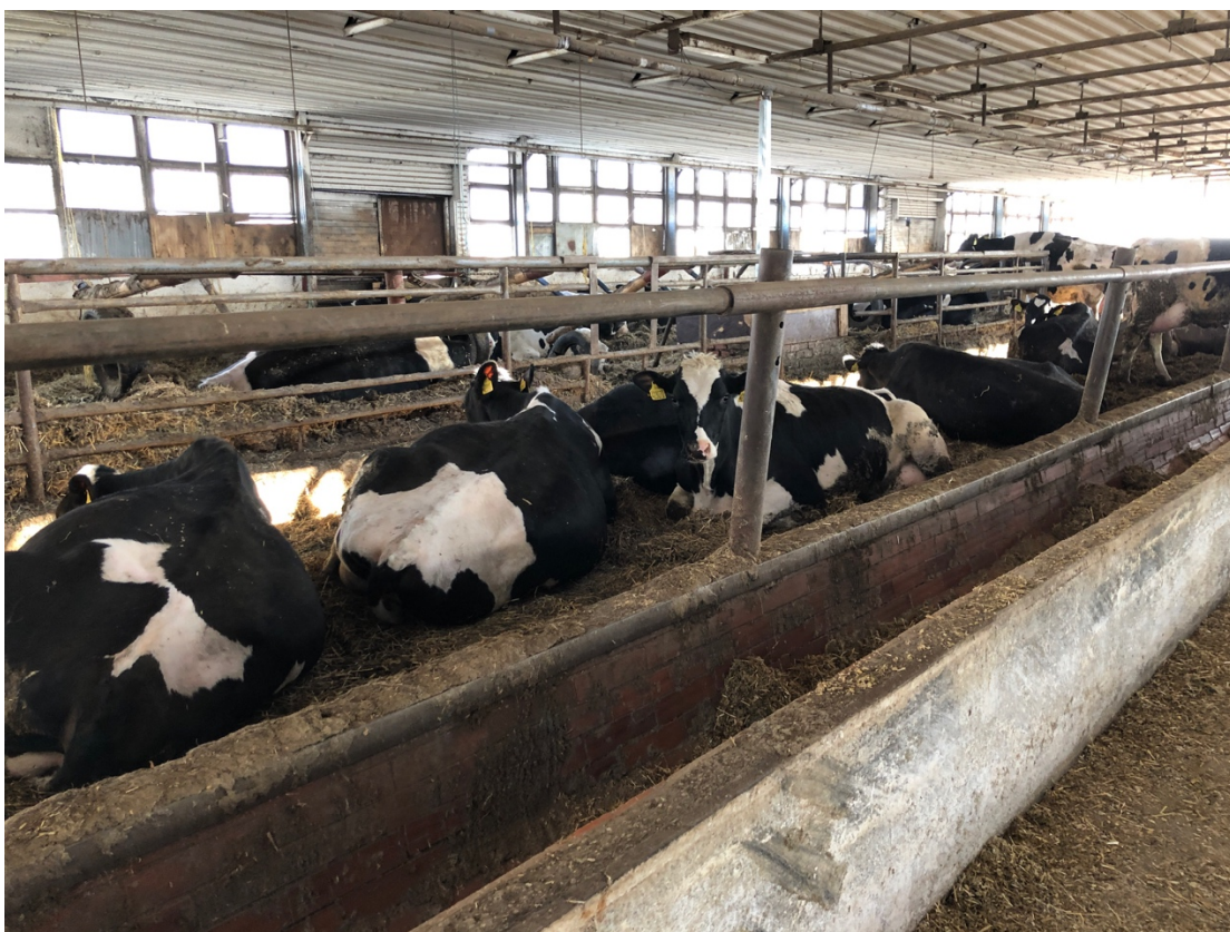
Obr. č. 4 Volné ustájení dojníc – dojnice lehají do krmné chodby z důvodu špatné konstrukce boxů
