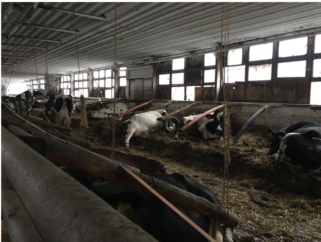
Obr. č. 4 Volné ustájení dojníc – dojnice lehají do krmné chodby z důvodu špatné konstrukce boxů
