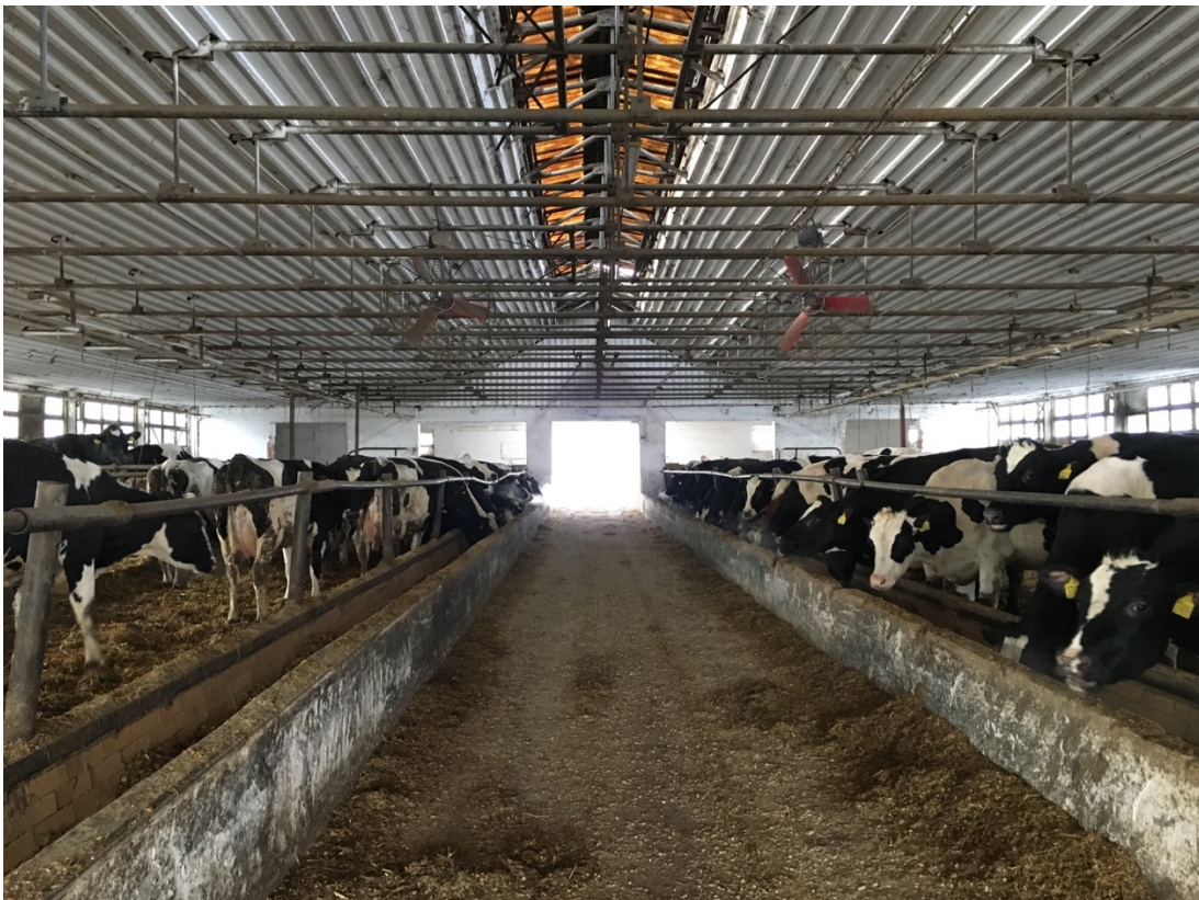
Obr. č. 2 Hala pro dojnice – sekce jsou oddělené krmnou chodbou
